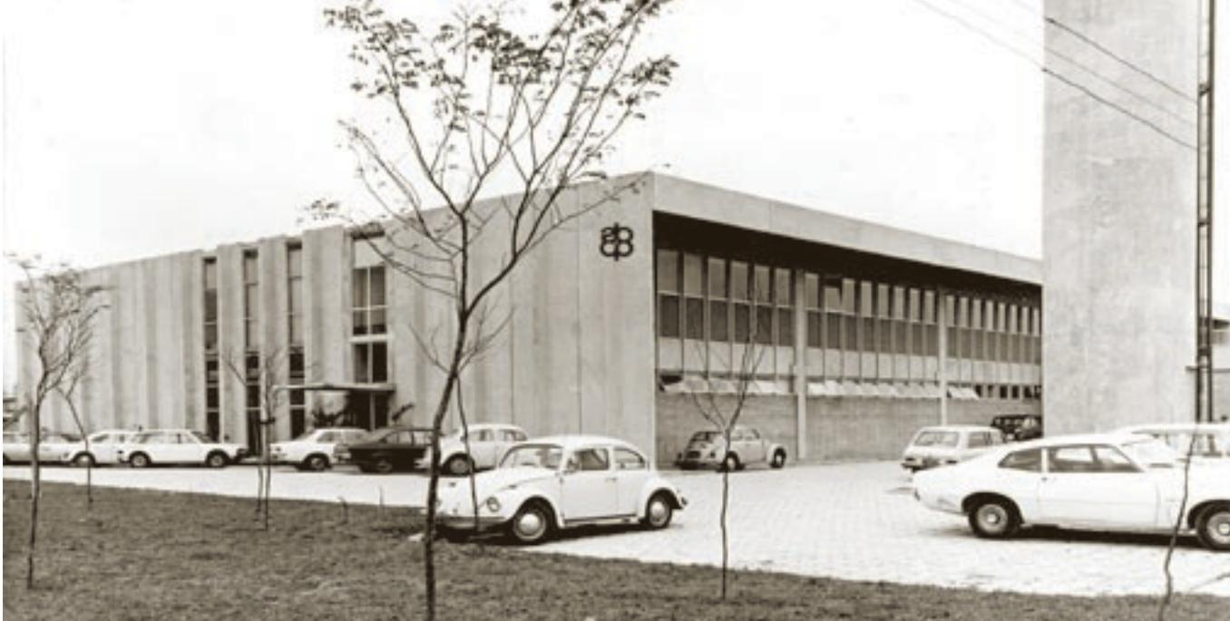
Sede da ABCP a partir de 1976, projetada em estrutura pré-fabricada de concreto.
