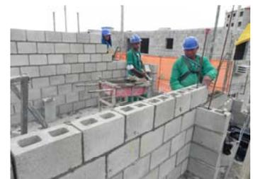
Por outro lado o bloco de concreto também pode ser empregado estruturalmente, compondo a alvenaria estrutural com blocos de concreto, um sistema construtivo no qual as paredes compõem a estrutura da edificação, além de desempenharem a
