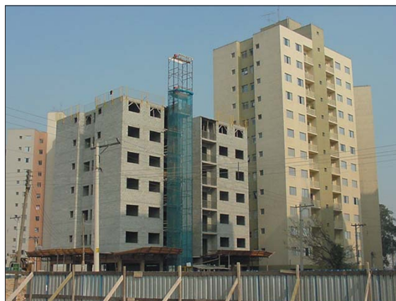
Figura 20 - Grade de Proteção no Andar
