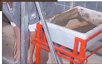
Figura 13 - Caixote de argamassa
