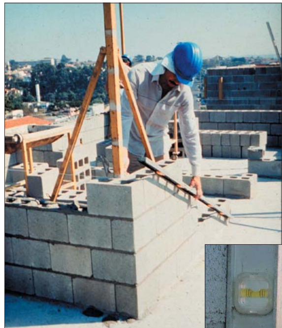
Figura 17 - Régua Prumo-nível
