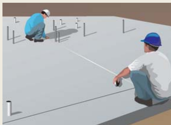
Fig. 8 - Marcação das direções da parede
