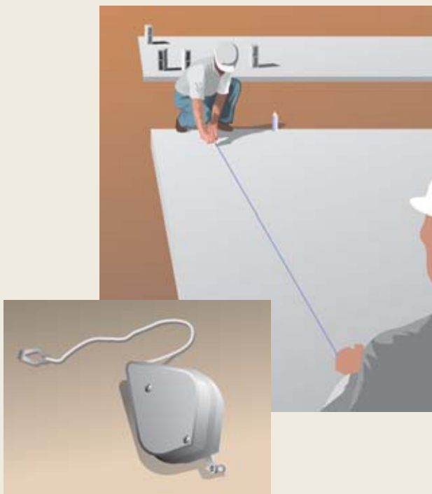
Fig. 7 - Marcação das linhas de referência das medidas
