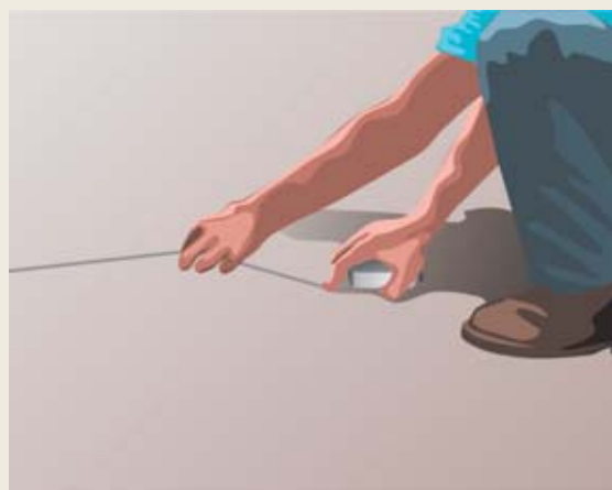
Fig. 9 - Utilização da linha traçante (cordex)
