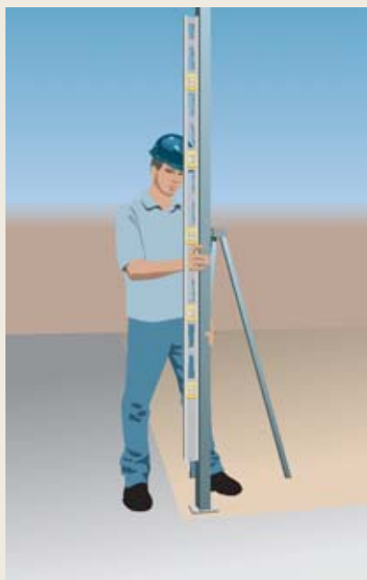
Fig. 18 - Posicionamento com régua prumo-nível
