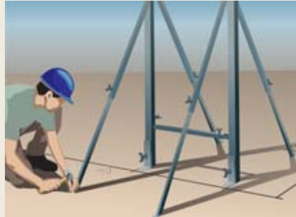
Fig. 23 - Fixação do gabarito de porta
