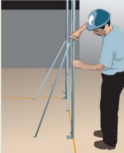
Fig. 21 - Transferência da referência de nível
