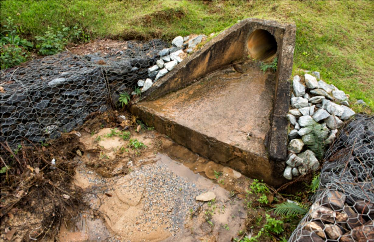
Vista de uma das bacias de retenção (1) implantadas e das canaletas impermeabilizadas (2) que conduzem água ao dique implantado ao fundo do terreno.
