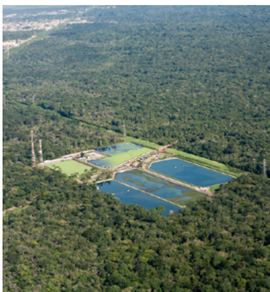
Vista aérea da ETE: destaque para as LFs nas laterais e LM ao centro. (Crédito: Reprodução site Riviera).
