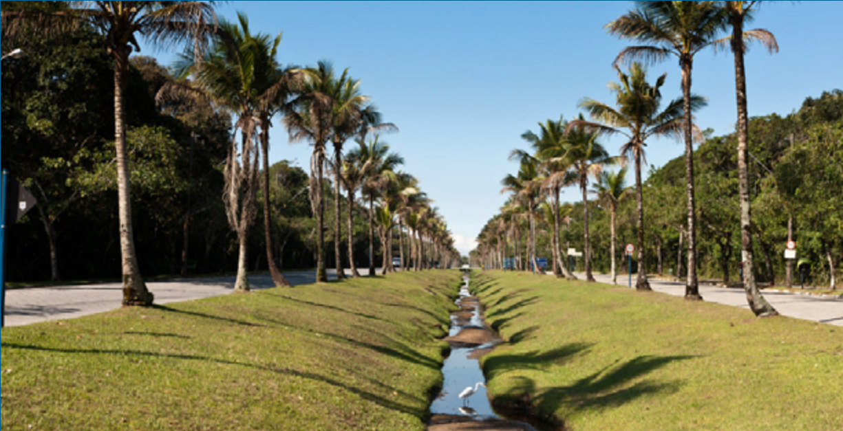
Canais de drenagem, áreas com cobertura vegetal e pavimento intertravado garantem eficiência à drenagem urbana. (Crédito: Valdete Silva).
