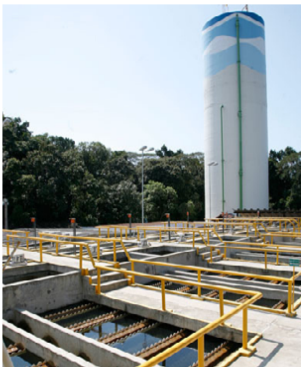
ETA: destaque para reservatório em concreto com 40m de altura. (Crédito: Ucha Aratangy).
