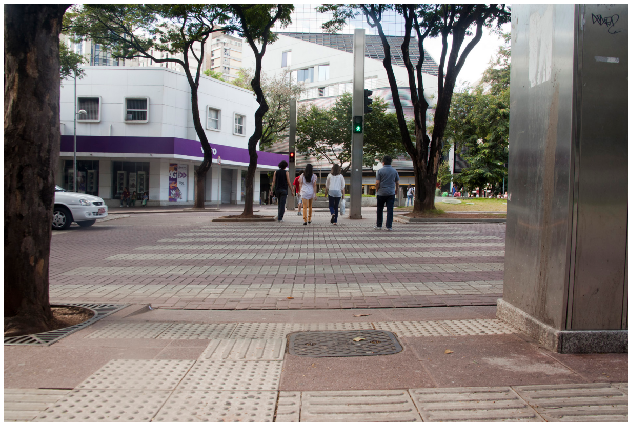
Travessia Elevada Para Pedestres Fonte: Arquivo Prefeitura de Belo Horizonte
