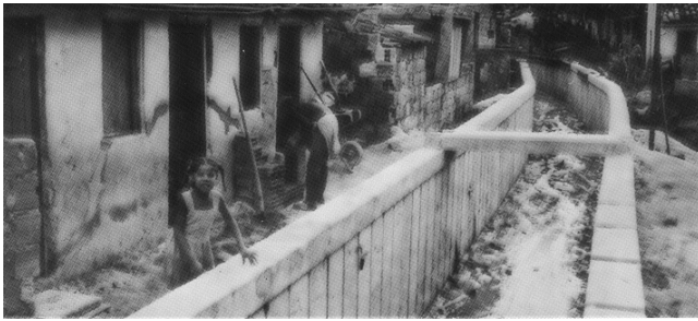
Revestimento de canais
