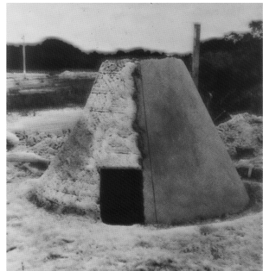
Silos para cereais
