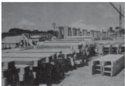
FOTO 3 - Estocagem de peças para revestimento de canal - Usina da RENURB, Salvador/BA
