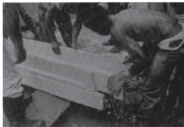
FOTO 8 - Montagem dos módulos de revestimento - Encaixe da peça lateral no poço de fundo
