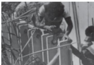
FOTO 11 - Montagem dos módulos de revestimento de canais - Fixação dos módulos
