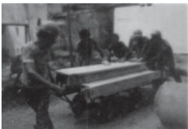
FOTO 7 - Transporte das peças para revestimento de canais - Interior do canteiro
