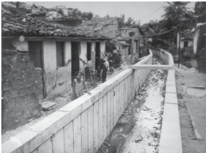
FOTO 25 - Bom Juá - Salvador/BA - Canal revestido em módulos pré-moldados de argamassa armada
