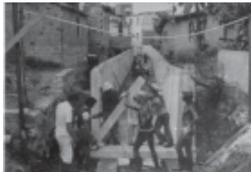
FOTO 10 - Montagem dos módulos de revestimento de canais - Armação do módulo
