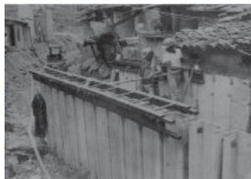
FOTO 12 - Viga de coroamento dos canais - Assentamento das formas
