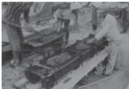
FOTO 2 - Concretagem das peças para revestimento de canais - Peça lateral
