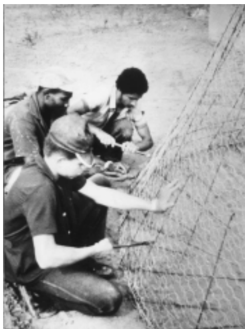
FIGURA 22 - CEPED - Centro de Pesquisas e Desenvolvimento/BA Silos de argamassa armada (capacidade = 5 m 3 )
