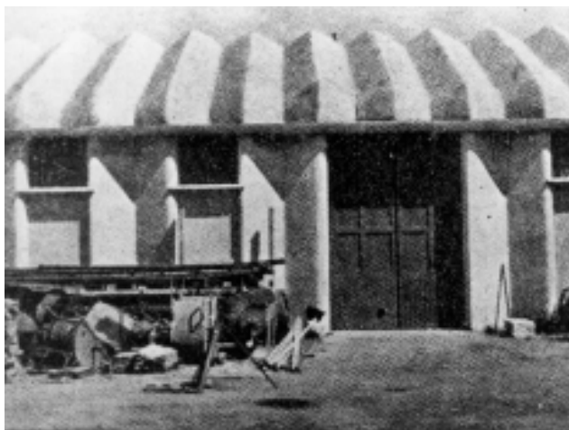
FIGURA 5 - Barracão de elementos pré-moldados de argamassa armada (comprimento = 22 m; largura = 11 m e espessura da parede = 30 mm)
