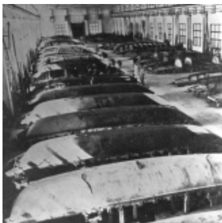
FIGURA 16 - Estaleiro para produção de embarcações de argamassa armada
