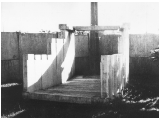
FIGURA 23b - Companhia de Renovação Urbana de Salvador/BA Canais de drenagem
