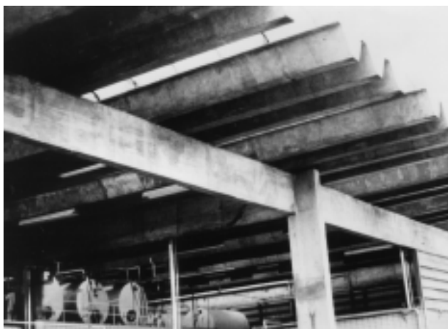
FIGURA 18b - Fábrica de Laticínios de São Carlos/SP Aspecto final da cobertura
