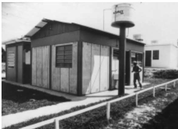
FIGURA 25a - Associação Brasileira de Cimento Portland Moradia de argamassa armada - Vista geral
