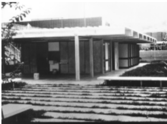
FIGURA 24a - Fábrica de Escolas do Rio de Janeiro/RJ Escola pré-fabricada de argamassa armada
