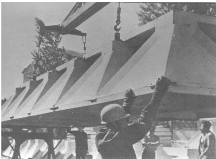
FIGURA 13 - Elementos de piso e cobertura - URSS
