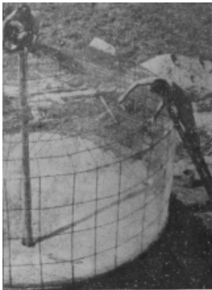
FIGURA 21 - Projeto Ferrocimento - CE Silos de argamassa armada capacidade = 50 m 3
