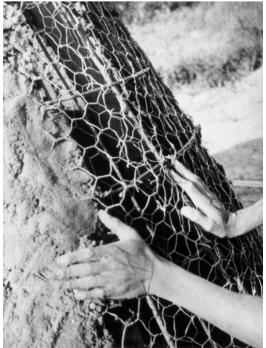
FIGURA 8b - Fase de argamassagem manual sobre a tela
