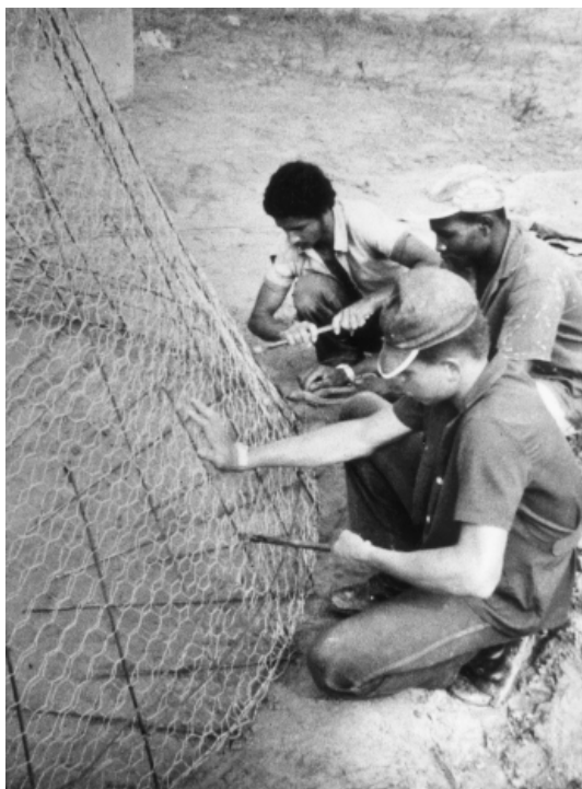
FIGURA 8a - Fase de amarração da tela às armaduras discretas
