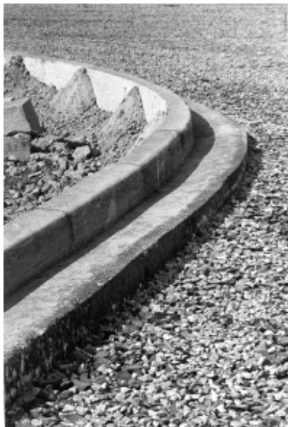
FOTO 1 - Meio-fio e sarjeta executados. Trecho em curva
