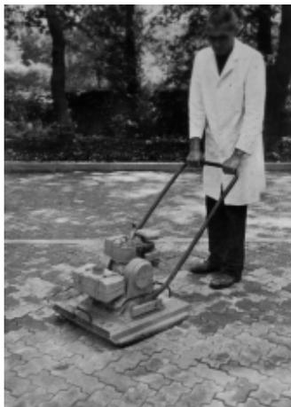
Durante a vibração, uma camada de areia fina ou pó-de-pedra deve ser espalhada sobre a superfície, para garantir o preenchimento completo dos espaços das juntas do pavimento e o intertravamento entre os blocos, fator importante para a durabilidade do pavimento.
