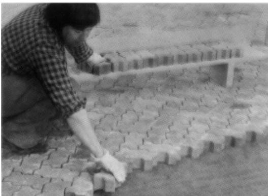
O acabamento junto às guias ou interrupções no pavimento (bueiros, caixas de inspeção etc.) é feito com blocos serrados ou cortados, tomando-se o cuidado para que fiquem levemente mais elevados do que essas interrupções (aproximadamente 3 mm) e observando-se a dimensão mínima de um quarto de bloco.
