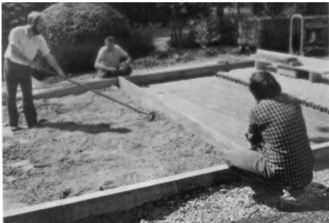
O assentamento dos blocos deve ser iniciado a partir de um meio-fio lateral e em ângulos retos, em relação ao eixo da pista, devendo ser dispostos o mais próximo possível um do outro, de maneira a garantir o intertravamento. Os blocos retangulares devem ser assentados na forma de espinha de peixe e nunca alinhados. Já para os blocos segmentados admite-se qualquer uma das duas formas de assentamento.
