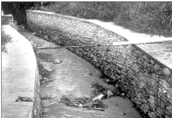
FOTO 7 - Revestimento de canal com solo-cimento ensacado
