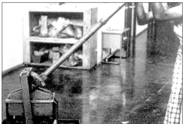
FOTO 5c - Compactação através de alavanca manual
