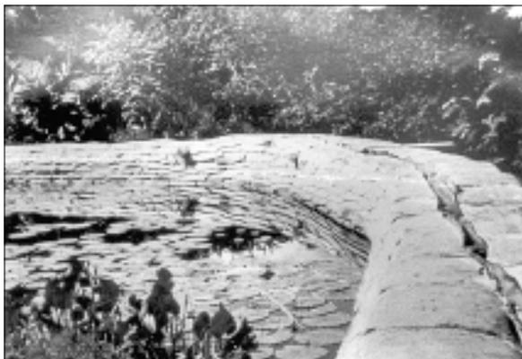
FOTO 10 - Pequena barragem utilizando solo-cimento ensacado
