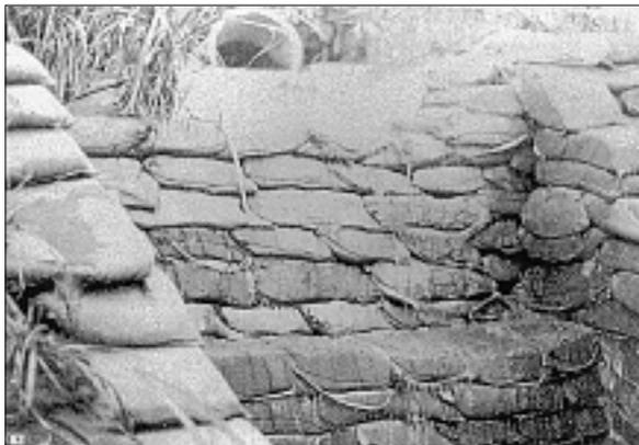
FOTO 9 - Saída de galeria com dissipador de energia em solo-cimento ensacado
