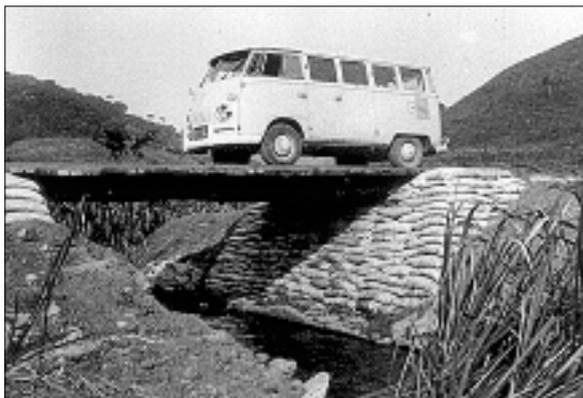
FOTO 8 - Pequena ponte com cabeceira de solo-cimento ensacado
