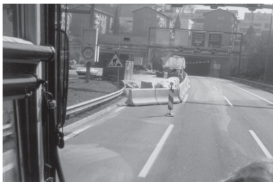
FOTO 5 - Barreiras pré-moldadas usadas para redirecionamento do trânsito
