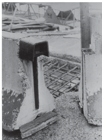
FOTO 2 - Perfil pré-moldado com ancoragem
