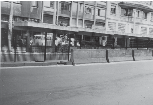
FOTO 13 - Barreiras divisórias de faixas exclusivas para ônibus - São Paulo (SP)
