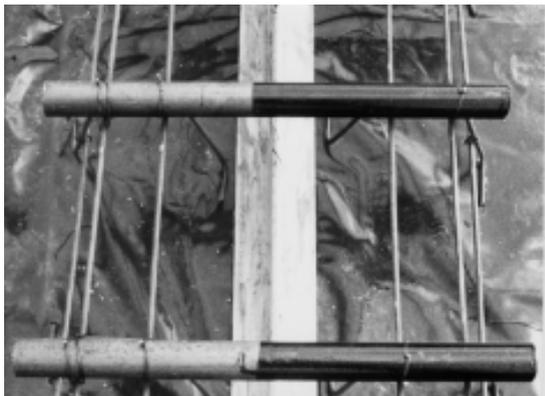
**FIGURA 56** - Esquema de dispositivo de apoio (*caranguejos*) para as barras de transferência (tipo usado em pavimentos de, no mínimo, 30 cm de espessura)
