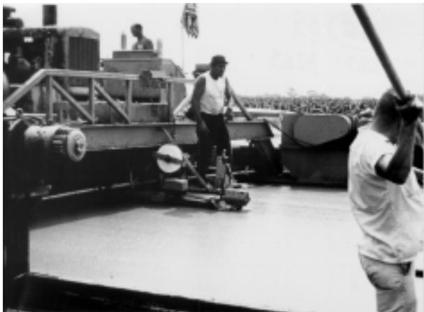
**FIGURA 59** - Junta longitudinal de seção enfraquecida moldada no concreto fresco
