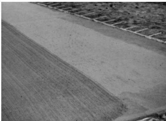
**FIGURA 47b** - Superfície resultante da aplicação da vassoura de piaçava
