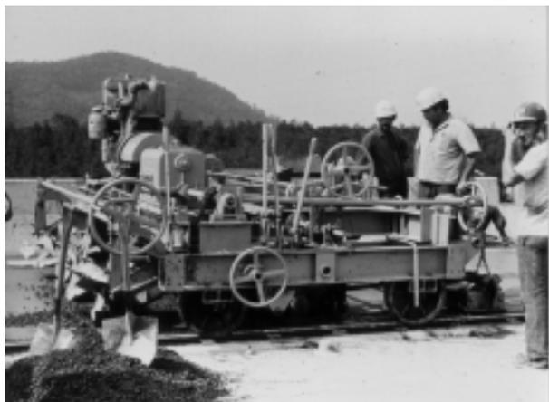
**FIGURA 7** - Equipamento sobre fôrmas-trilho
