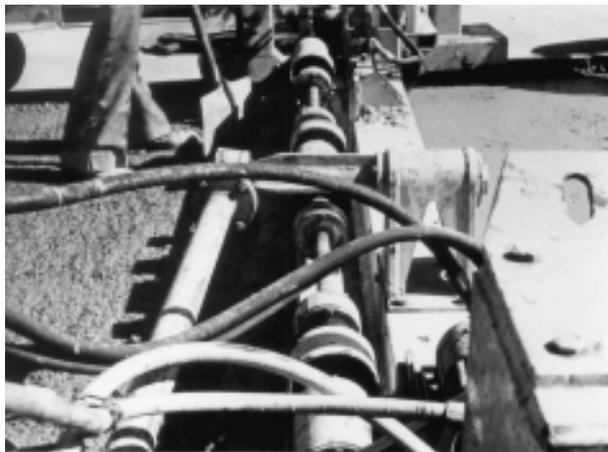
**FIGURA 35a** - Equipamento sobre fôrmas-trilhos — aplicação de vibro-acabadora isolada do conjunto
