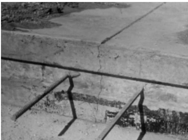
**FIGURA 58** - Junta de construção de encaixe
