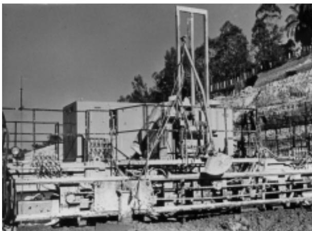
**FIGURA 13** - Equipamento de fôrmas deslizantes
