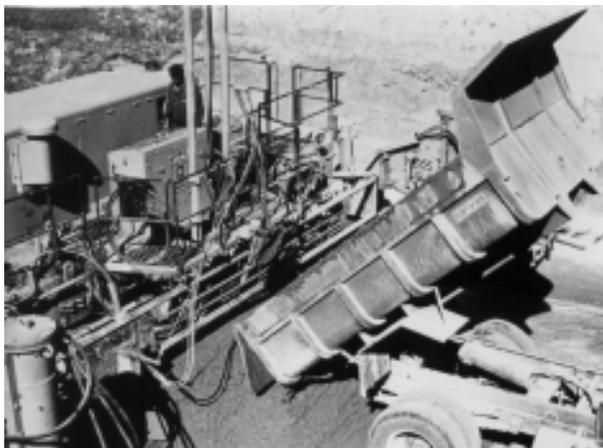
**FIGURA 29** - Retrolançamento do concreto, ou seja, postado o veículo de ré e à frente do equipamento
