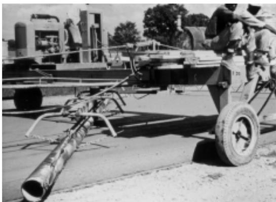
**FIGURA 46** - Aplicação do tubo cilíndrico metálico provido de mosas e saliências
