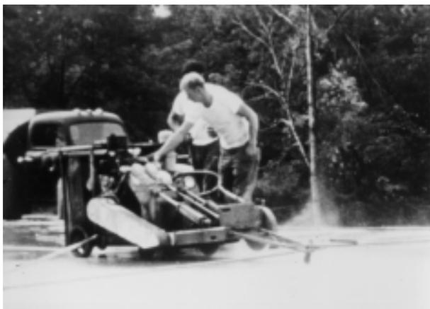
**FIGURA 60** - Junta longitudinal de seção enfraquecida serrada no concreto semi-endurecido
