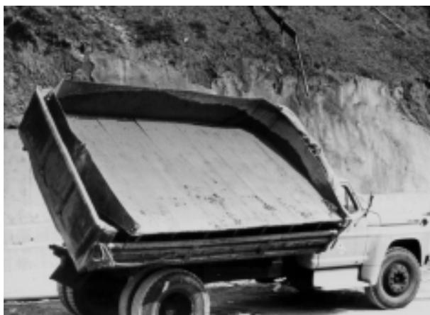
**FIGURA 28** - Lançamento de concreto por descarga lateral
