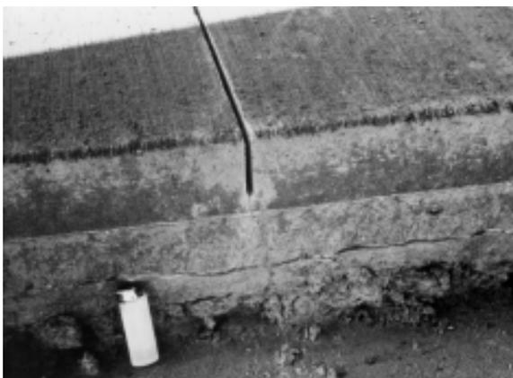
**FIGURA 51** - Junta transversal de retração recém-aberta por corte com serra
