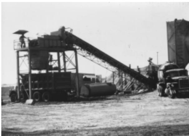
**FIGURA 20** - Usina central para concreto
