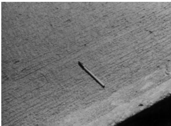
**FIGURA 48b** - Superfície resultante da aplicação da tira ou faixa de lona
