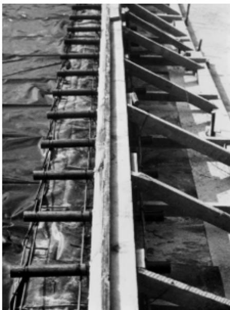
**FIGURA 64a** - Instalação da junta transversal de construção *planejada*
