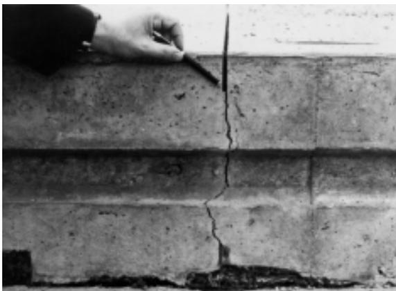
**FIGURA 52** - Junta transversal de retração serrada, vendo-se a fissura de retração já estabelecida
