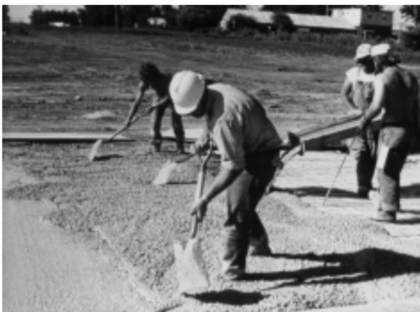
**FIGURA 30** - Espalhamento manual do concreto
