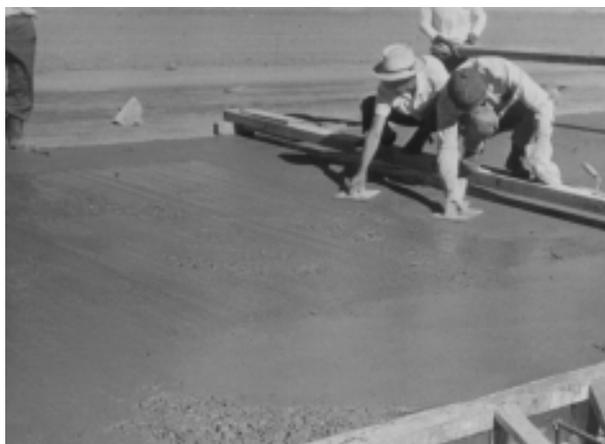
**FIGURA 43a** - Acabamento superficial e acerto das bordas longitudinais
