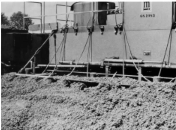
**FIGURA 31** - Recepção e distribuição mecânica do concreto pela pavimentadora de fôrmas deslizantes
