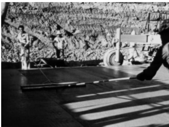
**FIGURA 39** - Aplicação de rolos leves cobertos de borracha, para a eliminação do excesso d'água superficial
