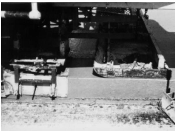
**FIGURA 14** - Vista lateral da fôrma deslizante (assinalada pela seta)
