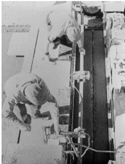
**FIGURA 54** - Juntas moldadas
