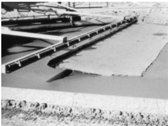
**FIGURA 48a** - Aplicação da tira ou faixa de lona no sentido longitudinal da pavimentação
