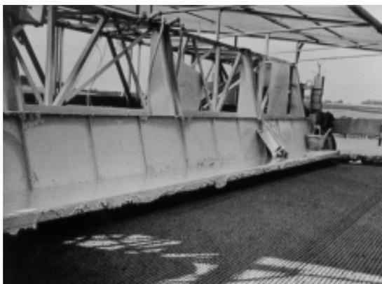
**FIGURA 44b** - Superfície do concreto fresco após a passagem do *pente* de fios metálicos não flexíveis
