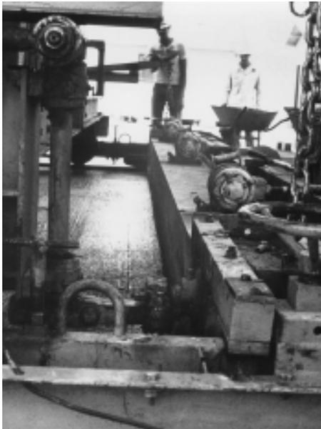
**FIGURA 35b** - Equipamento sobre fôrmas-trilhos — aplicação de vibro-acabadora acoplada ao conjunto
