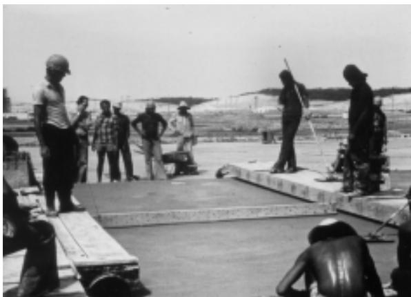
**FIGURA 38** - Nivelamento da superfície com a régua de 3 m de comprimento
