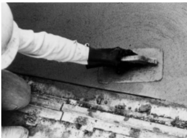
**FIGURA 43c** - Acabamento superficial e acerto das bordas longitudinais
