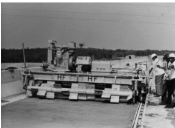
**FIGURA 10** - Eixo rotor frontal
