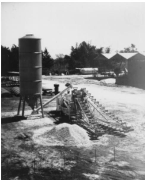
**FIGURA 24** - Central dosadora alimentada por pá-carregadora (cortesia CIBI)
