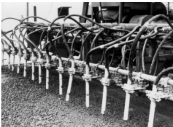
**FIGURA 33** - Equipamento sobre fôrmas-trilhos — aplicação dos vibradores de imersão
