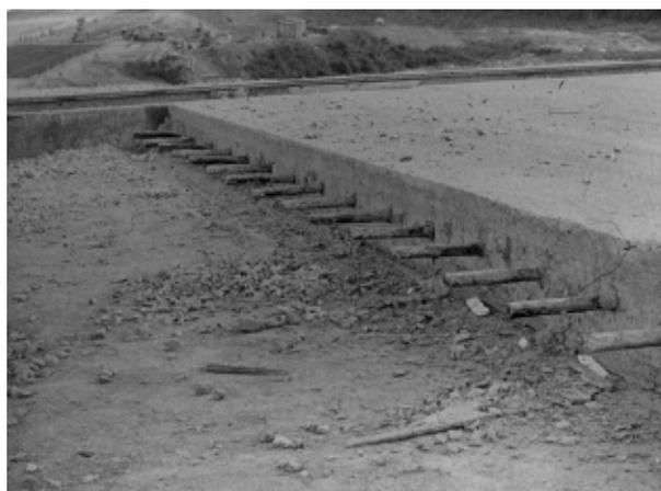
**FIGURA 64b** - Junta transversal de construção *planejada* já executada
