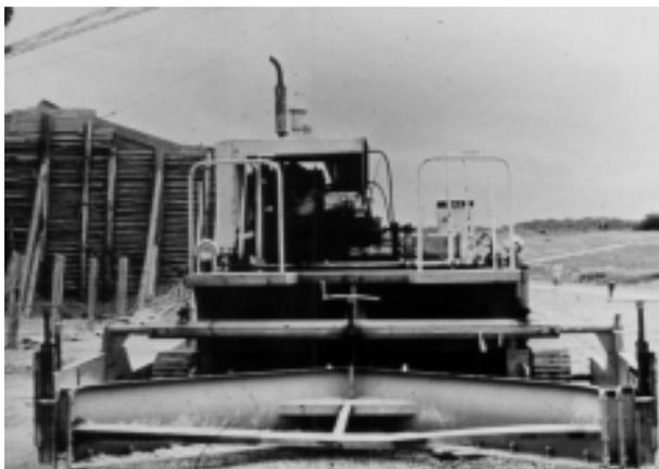
**FIGURA 9** - Distribuidora de concreto, regulável e com tração própria
