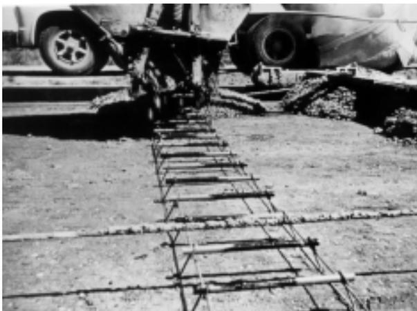
**FIGURA 55** - Barras de transferência dispostas ao longo da futura junta transversal
