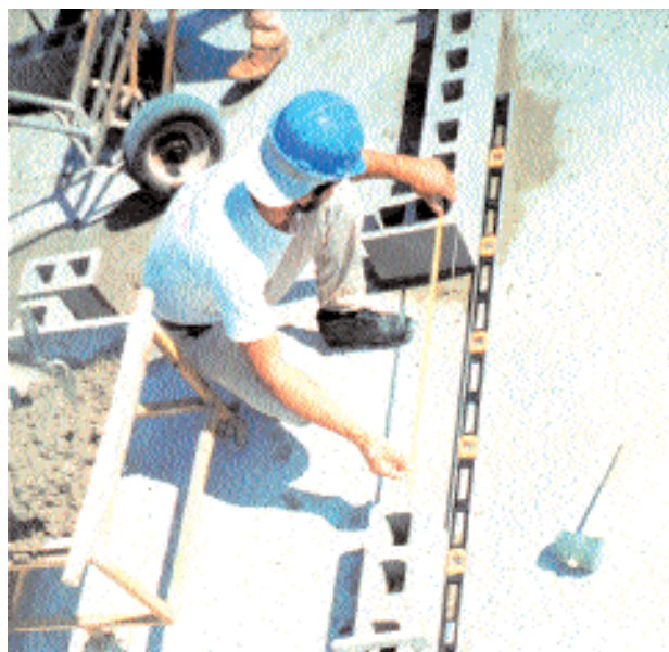
Assentamento da 1ª fiada
