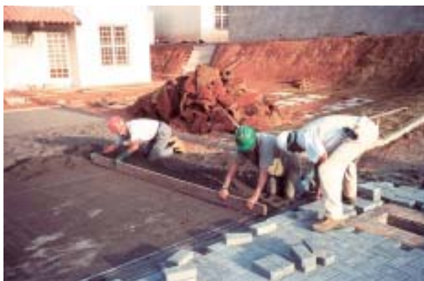
Espalhamento e nivelamento da areia
