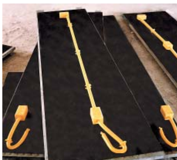
Eletrodutos nas fôrmas
