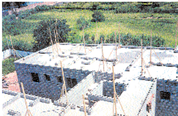
Finalização da etapa de marcação
