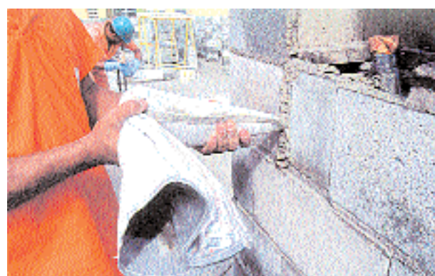
Aplicação de argamassa - juntas verticais
