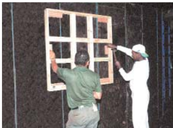
Posicionamento de contramarco
