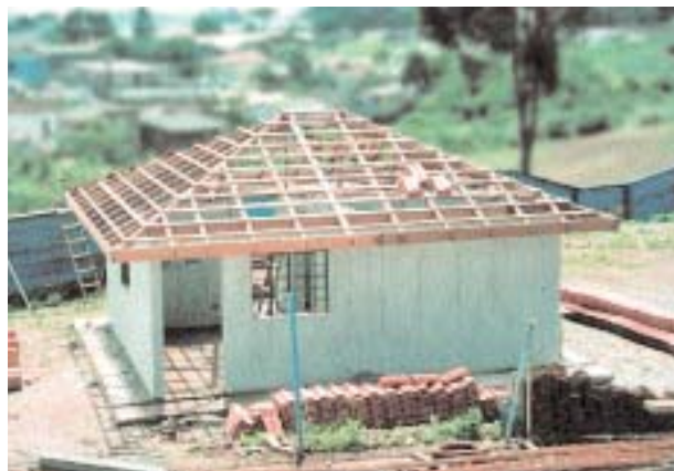
Estrutura de madeira
