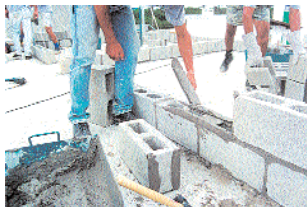
Aplicação de argamassa - junta horizontal
