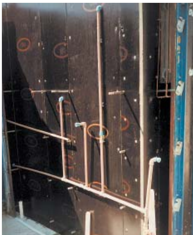
Kit hidráulico posicionado
