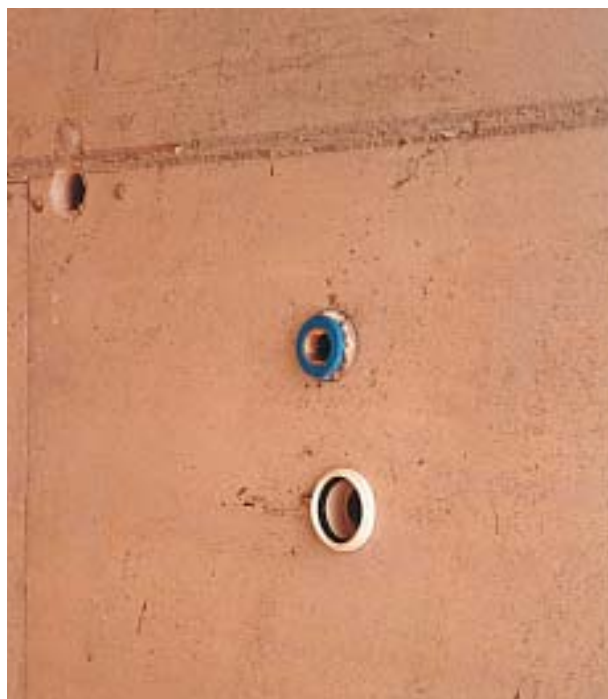
Instalação hidráulica pós-concretagem
