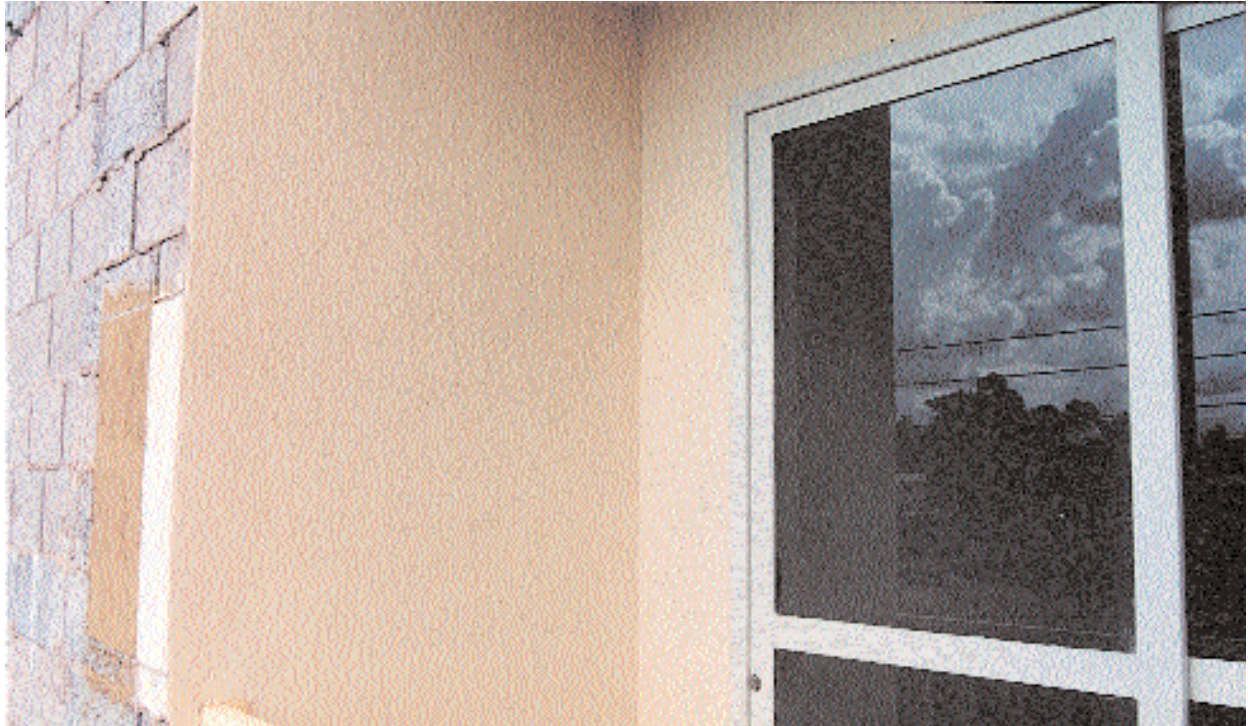
Revestimento - Argamassa
