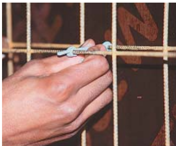
Colocação de espaçador
