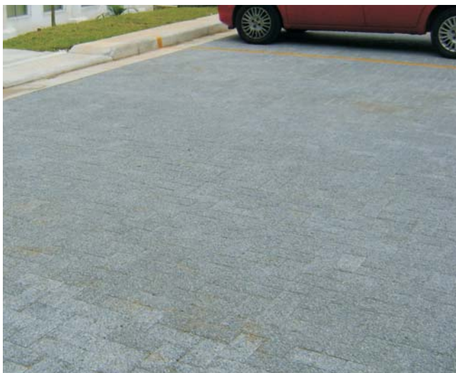
Figura 9 – Pavimento Intertravado Permeável com peça de concreto poroso
