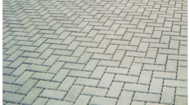
Figura 6 - Pavimento intertravado permeável com juntas alargadas
