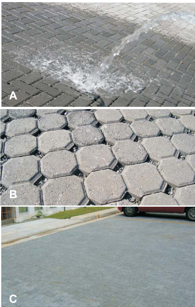
Figura 5 – Tipos de revestimento para pavimento intertravado permeável
