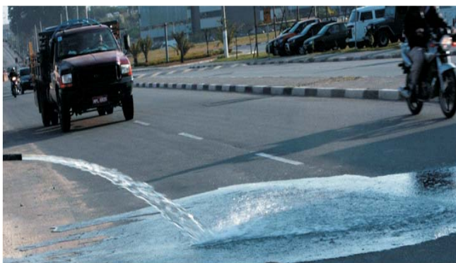
Figura 1 - Pavimento praticamente impermeável. Verifica-se a rápida formação de escoamento superficial da água.
