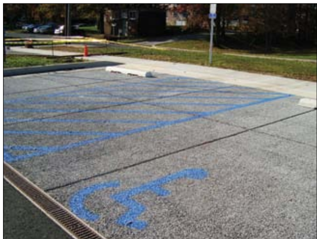
Figura 5 - Pavimento de concreto permeável
