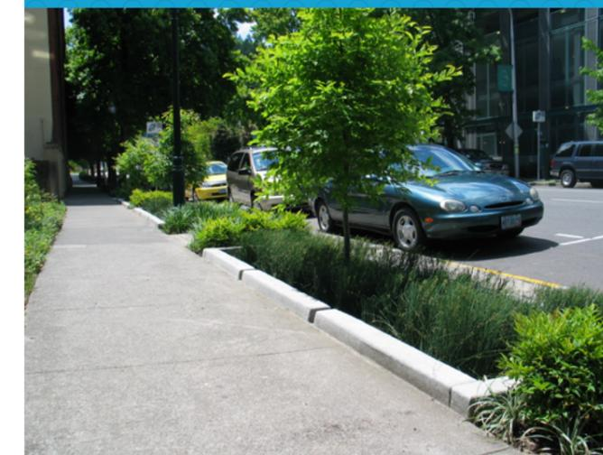
As setas tracejadas em azul (desenho ao lado) representam o fluxo das águas pluviais pela estrutura. A figura acima ilustra um jardim de chuva construído de acordo com o desenho técnico apresentado ao lado.
