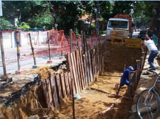
Escavação da vala onde será construído o microrreservatório.
