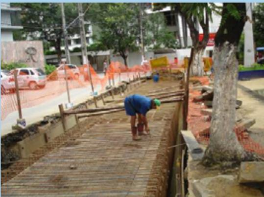
Concretagem do microrreservatório e realização da ligação deste com a rede de microdrenagem existente.
