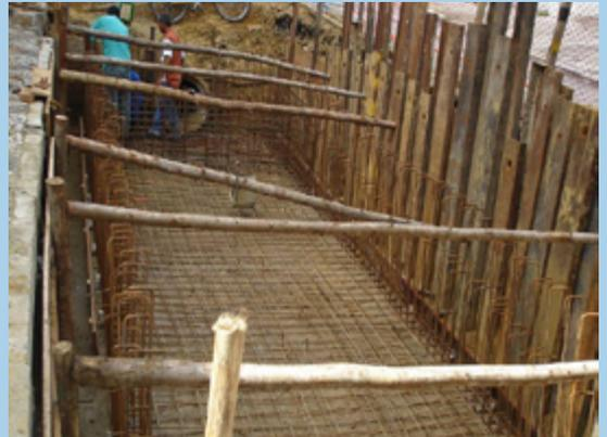
Montagem da armação do microrreservatório.
