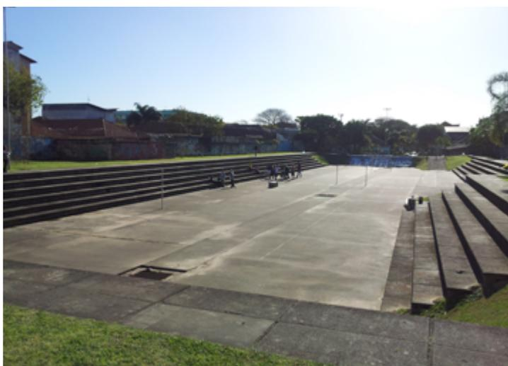
Reservatórios secos, que armazenam água apenas durante eventos de chuva e podem ser construídos com fundo impermeabilizado, quando há risco de contaminação de águas subterrâneas pelas cargas elevadas de poluentes. Impermeabilizações em concreto podem desempenhar outros tipos de funções, como a implantação de quadras de esportes e áreas de lazer.
