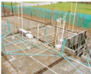
Devem ser evitadas "linhas" de redução da seção das paredes, que funcionariam com juntas de indução de fissuras.
