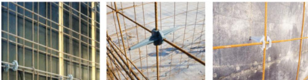
O sistema PAREDE DE CONCRETO utiliza concreto com alto índice de fluidez. Para evitar que os espaçadores sejam "arrastados" e saiam da posição durante a concretagem, as peças possuem elementos de fixação.
