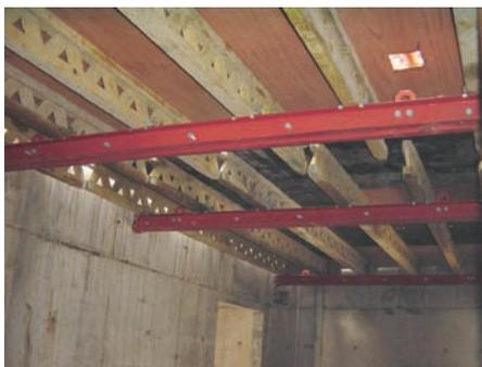
As plataformas de poço têm estabilidade garantida pela utilização de sistema de apoio, vigas e piso resistente.
