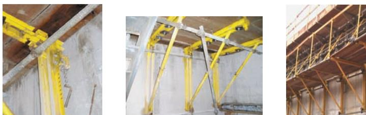
Os andaimes suspensos são fixados com insert e anel de apoio, que garantem a estabilidade do conjunto. Porém, acima do andaime o guardacorpo está fora dos padrões da NR-18, pois está sem travessão intermediário, rodapé e telas de fechamento.
