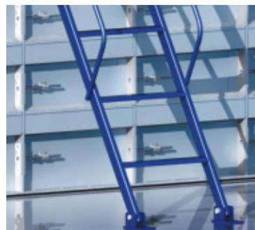
Escada com dimensionamento correto, com espaçamento uniforme entre os degraus, ultrapassa em 1,00 m [um metro] o piso superior, fixada no piso inferior e superior para que impeça o seu deslizamento e dotada de degraus antiderrapantes, atendendo a NR-18.
