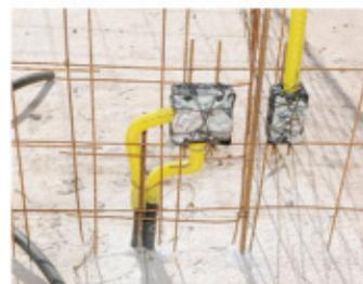
Caixas instaladas em posições exatamente "opostas" também dificultam o preenchimento de concreto nesses locais e prejudicam o conforto acústico.
