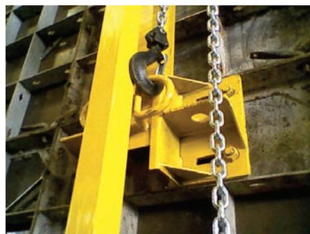
Para a movimentação e içamento das fôrmas é utilizada talha tipo catraca com capacidade de carga = 5000 kg com corrente para movimentação de 5 m.
