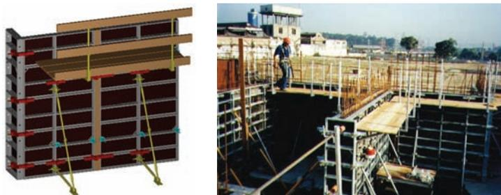
O sistema Concreform também possui consoles, que são a plataforma que será utilizada pelos trabalhadores para montagem e concretagem da parede. É preciso que eles possuam a largura mínima de três pranchões, dimensão não identificada na apresentação. Para tanto, ficam válidas as recomendações da NBR 6120, OSHA 3146 e ANSI Z 359 quanto à resistência e dimensionamento dos montantes superior e intermediário. É necessária a instalação de tela entre os travessões e os guardacorpos laterais.
