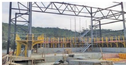
Os pórticos e andaimes suspensos atendem às exigências normativas, mas as escadas e os guardacorpos necessitam da instalação de telas fechando os travessões.
