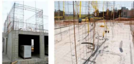
Em edificações baixas, normalmente, as telas têm sido posicionadas no eixo das paredes; já edifícios altos podem exigir tela dupla, sendo uma na face interna e outra na face externa da parede.
