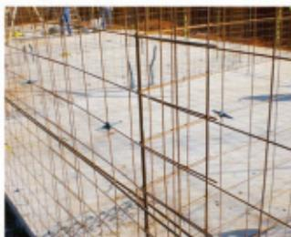
Auxiliam na montagem vertical das telas, mantendo-as em pé e no posicionamento correto.
