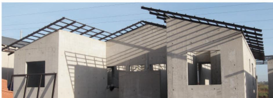
A parede de concreto possui ótima resistência contra agentes agressivos, é praticamente estanque à água e a gases, e também não necessita de elementos adicionais para isolamento termoaústico. Devido ao excelente padrão dos sistemas de fôrmas e do tipo de concreto empregado, a superfície das paredes não necessita de revestimento de argamassa.
