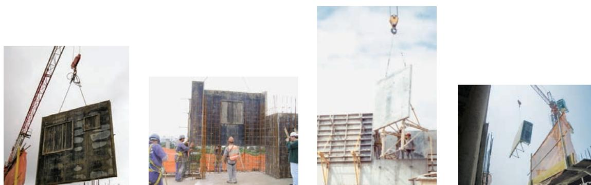
É preciso que os cabos de aço utilizados para o içamento do conjunto não comprometam a segurança pelo mau dimensionamento.
