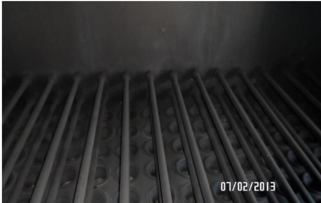
**Figura 6. Inspeção do plenum do filtro protegido, com espelho e tubos sopradores.**
