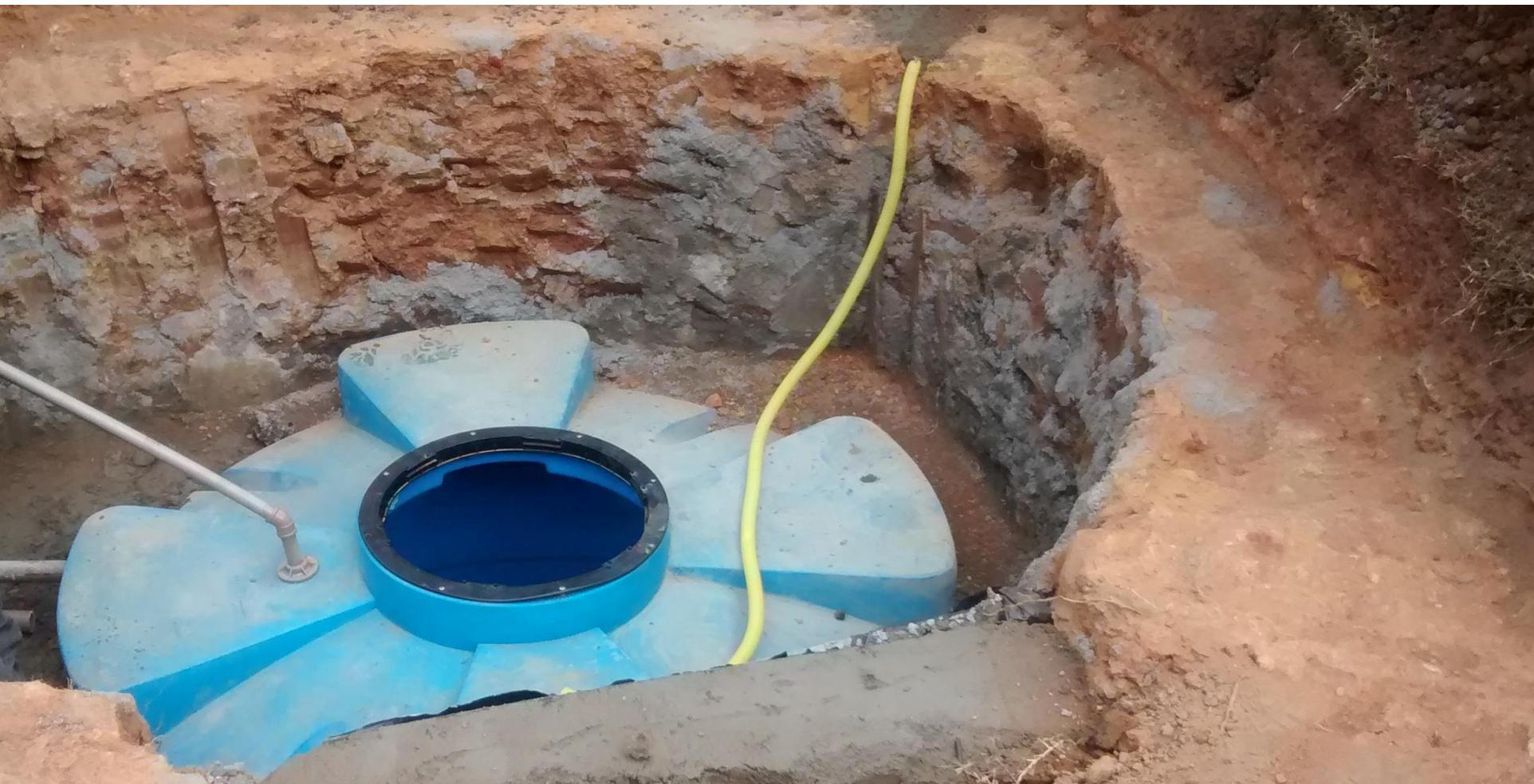
O nível da cisterna deve levar em consideração o nível da entrada do tubo dreno do pavimento e a saída do ladrão da cisterna, que deve ser direcionado por gravidade até o sistema de drenagem de águas pluviais
