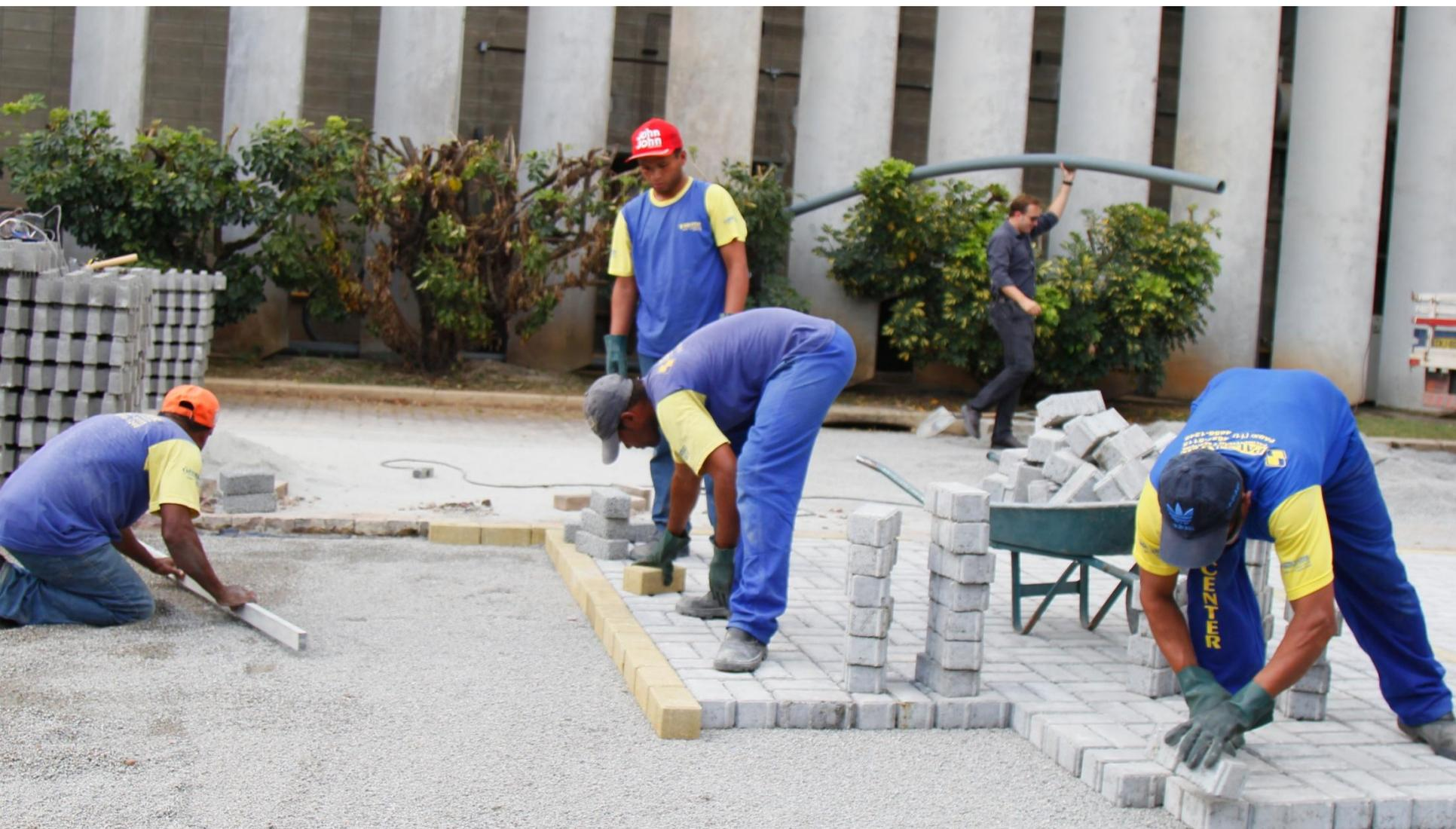
A camada de revestimento não deve ser compactada antes da colocação das peças
