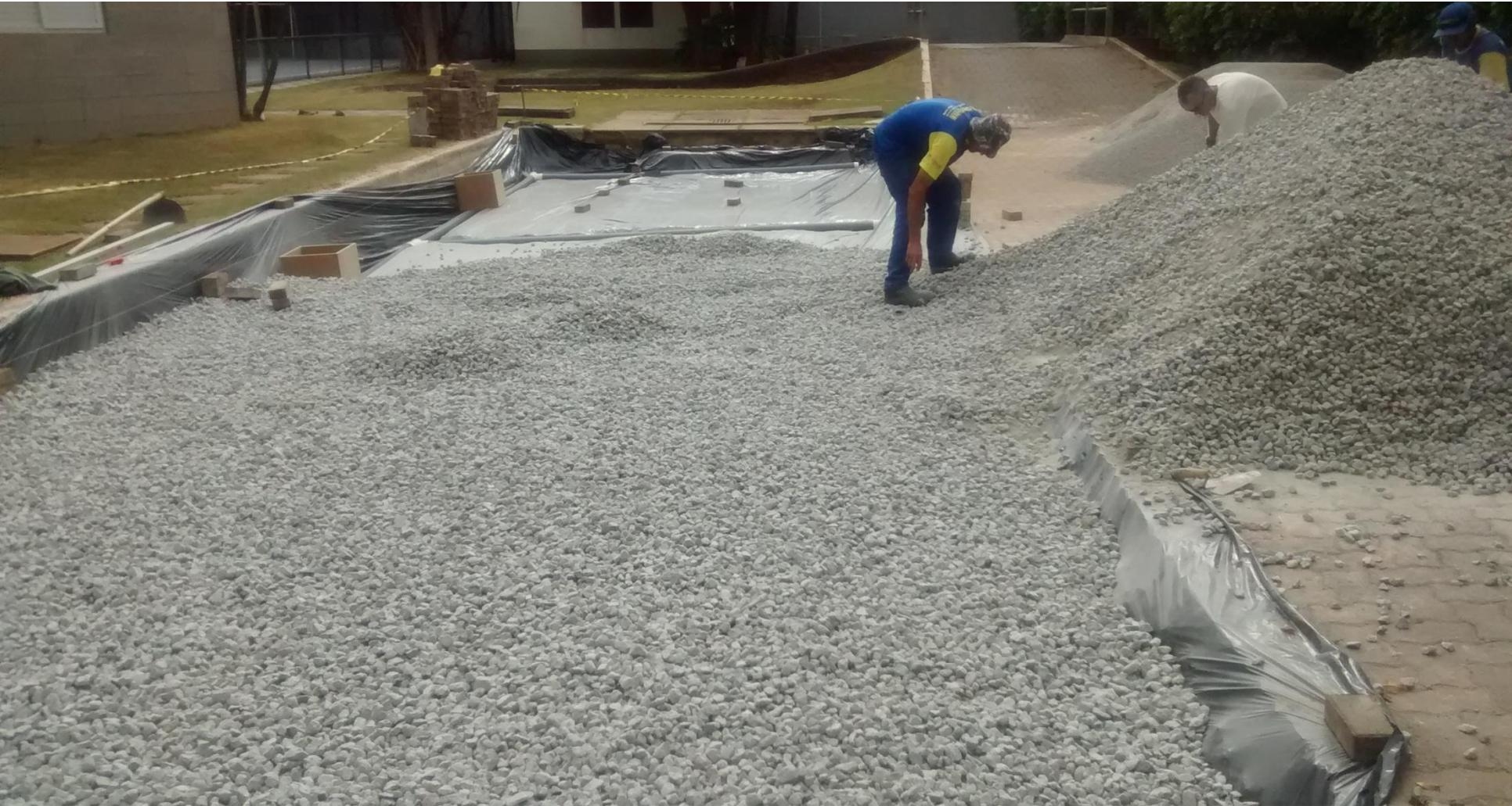
Material de base: 20 cm de brita 19 mm, sem finos e com granulometria uniforme (maioria das partículas em torno de 19 mm)
