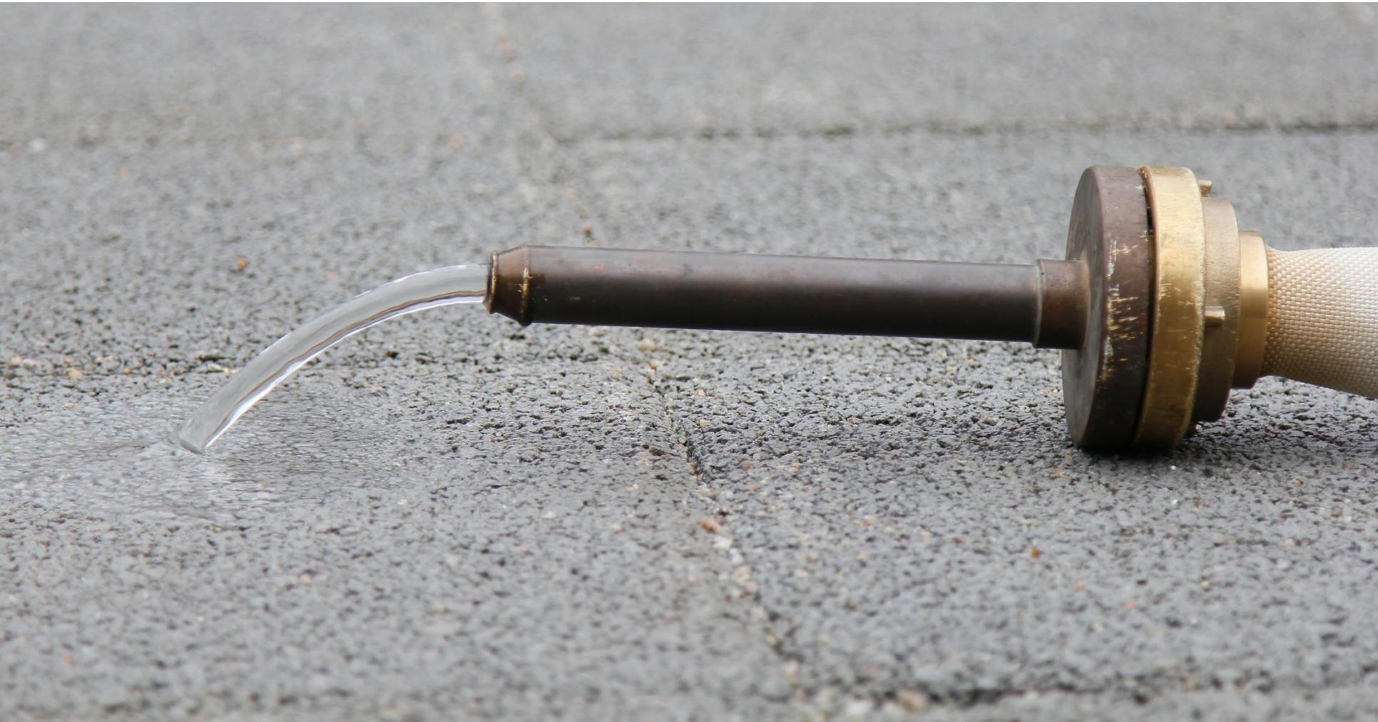
Visualização da água percolando rapidamente pelo revestimento do pavimento permeável. 100% de área permeável
