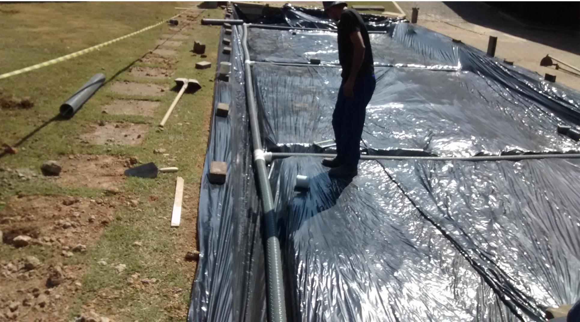
Instalação dos tubos dreno de 4" (acelera a retirada da água da estrutura e direciona a coleta para a cisterna)
