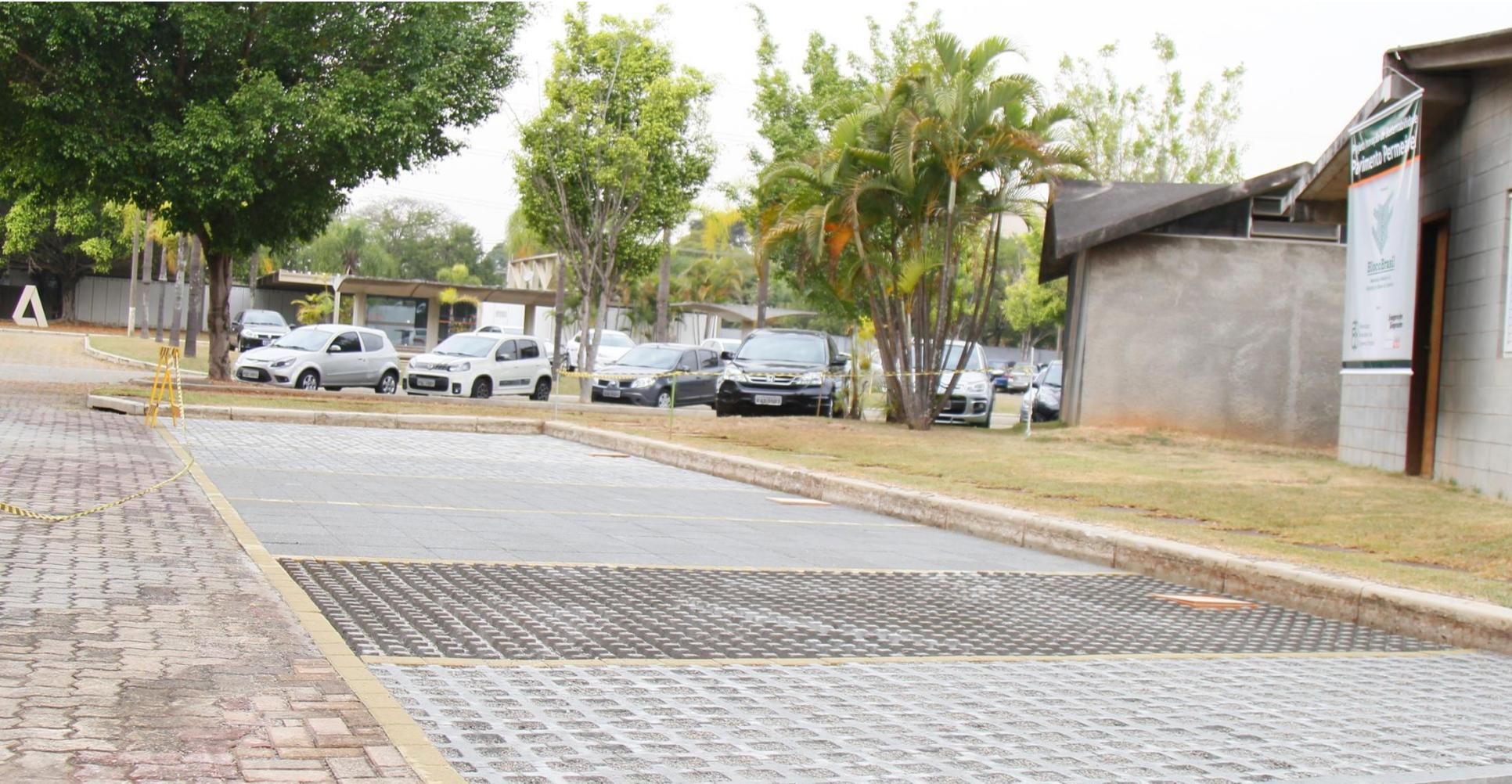
Após a compactação, deve-se verificar se o material de rejuntamento está preenchendo todas as juntas e espaços por onde a água irá percolar. É feita a limpeza da superfície, verifica-se se há alguma peça quebrada ou desnivelada e é feita a liberação do pavimento permeável.
