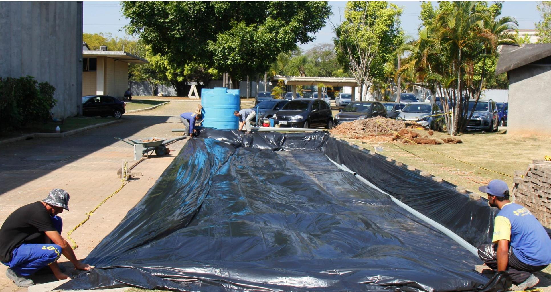
colocação da manta impermeável para proteção do solo (evitar saturação do solo de baixa permeabilidade e aumentar a condição de armazenamento da água). Proteção do entorno do pavimento no encontro com as áreas impermeáveis
