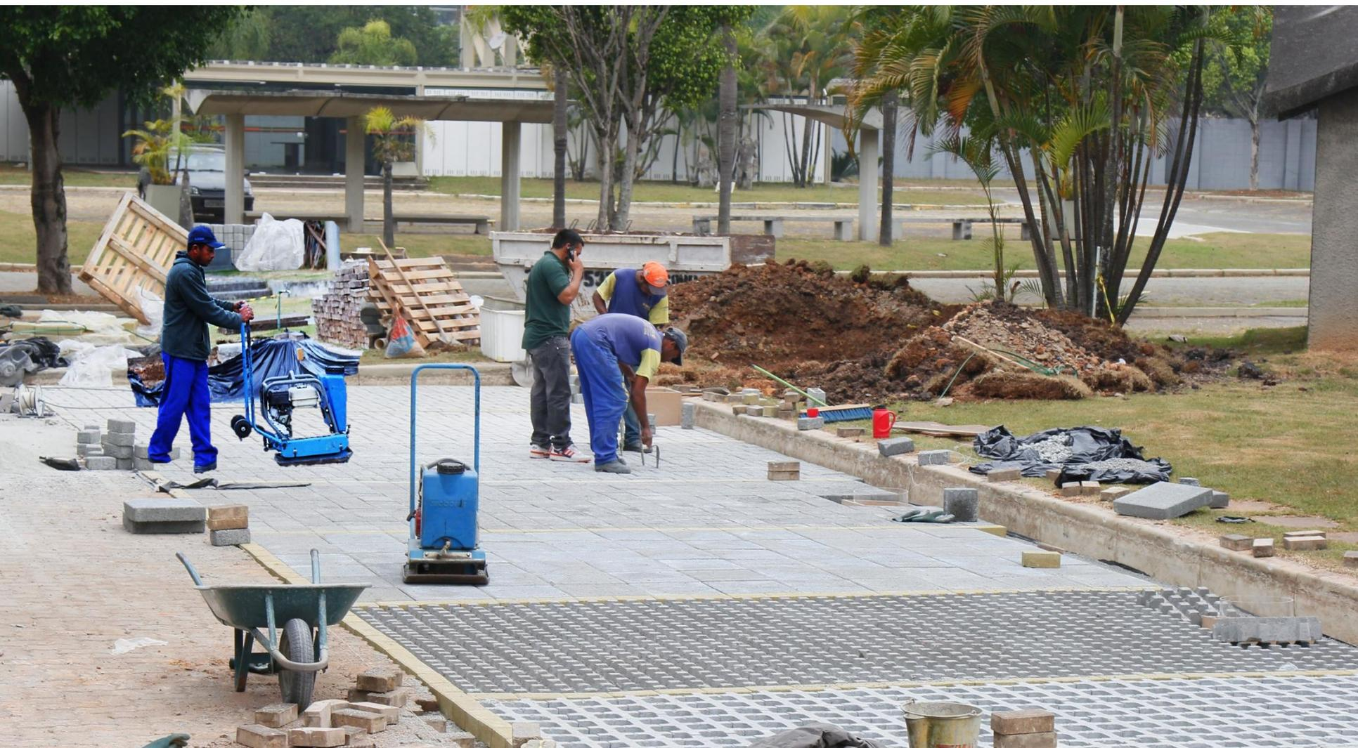
Após a colocação do material de rejuntamento, deve-se retirar o excesso e realizar a compactação do revestimento com placa vibratória e com proteção de borracha para, não danificar as peças ou placas do revestimento
