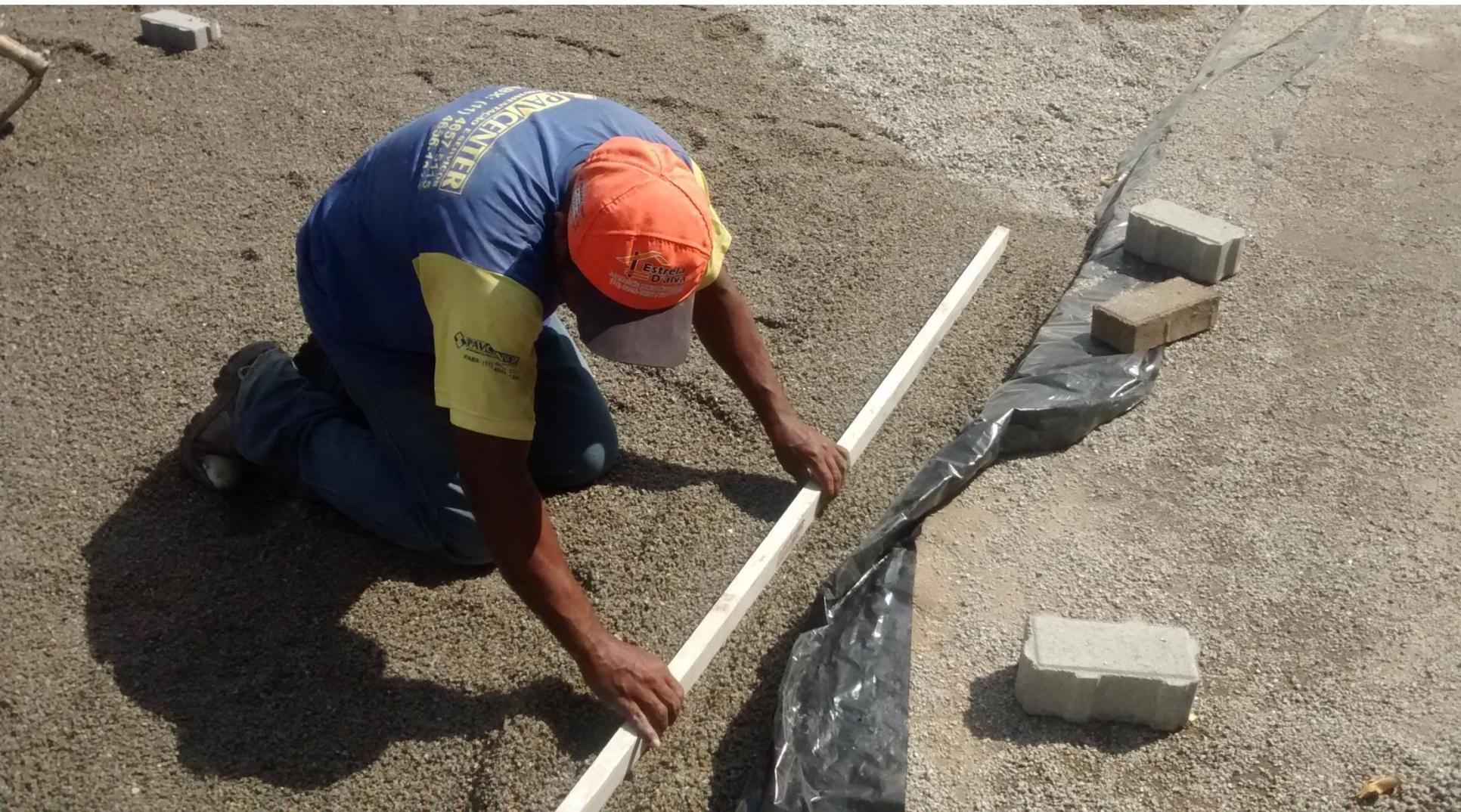
O material de revestimento: 4 cm de brita 6,3 mm, sem finos e com granulometria uniforme (maioria das partículas em torno de 6,3 mm)
