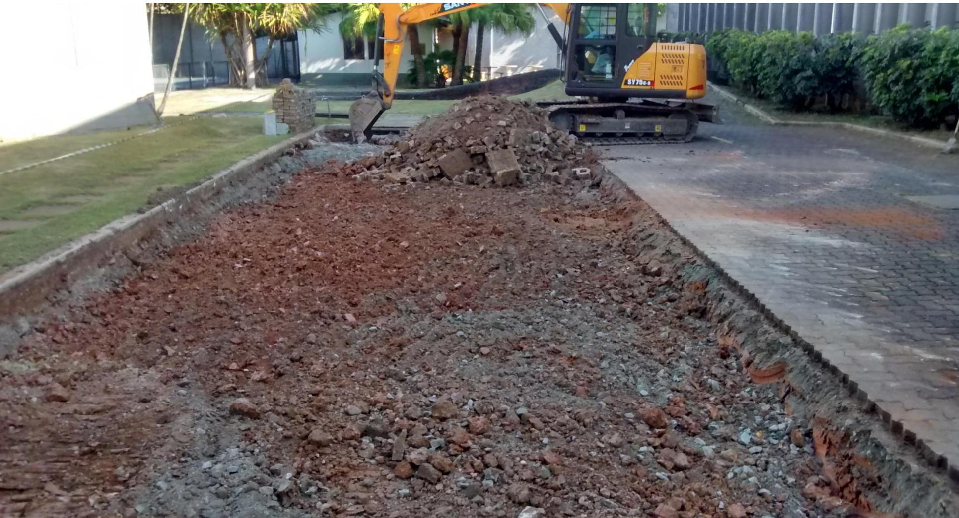
Retirada da base com estrutura fechada (sem infiltração). A altura da estrutura depende das condições locais de chuva e necessidade de armazenamento. Verifique a norma NBR 16416.
