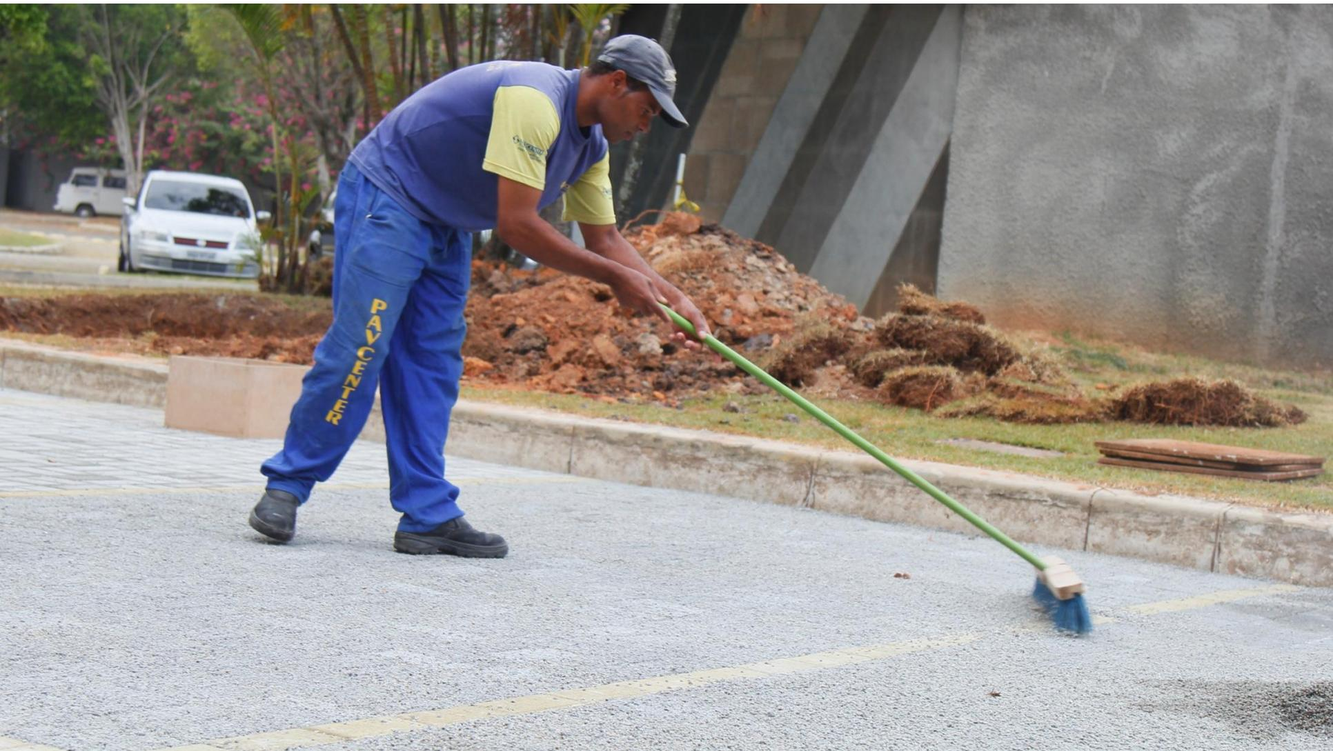
Espalhamento do material de rejuntamento após a colocação de todo revestimento
