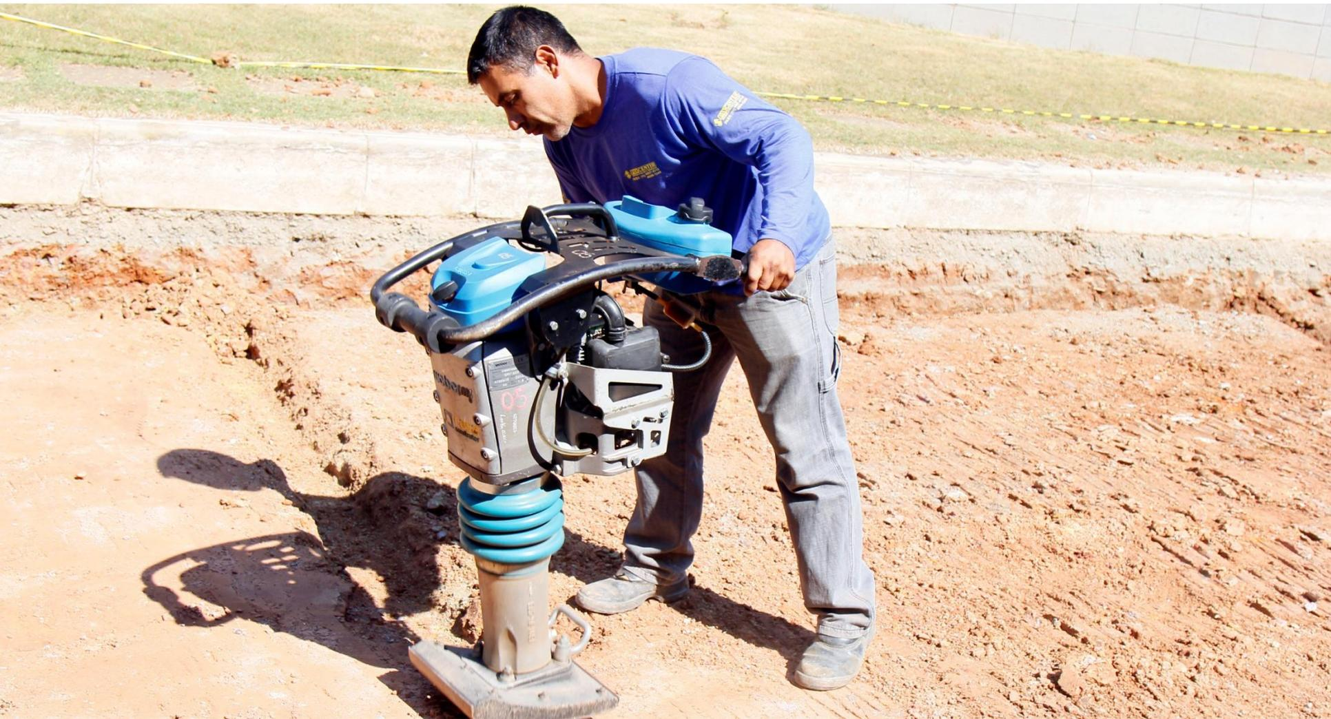
Compactação do subleito. Deve-se verificar a necessidade ou não do uso da manta plástica, conforme o tipo de solo. A manta é recomendada para solos argilosos de baixa permeabilidade. Verifique a norma ABNT 16416.
