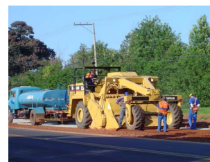
Reciclagem com adição de cimento - SP-351 - Tupã/SP
