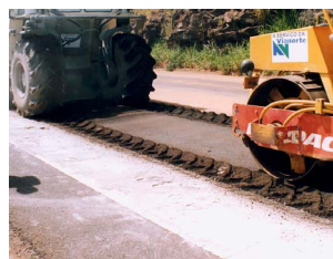
Reciclagem com adição de cimento - Via Norte/SP
