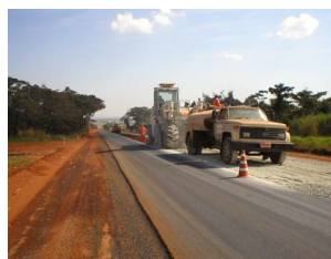
Reciclagem com adição de brita e cimento - SP-253
