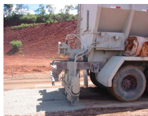
Distribuição de cimento na BR-459-MG
