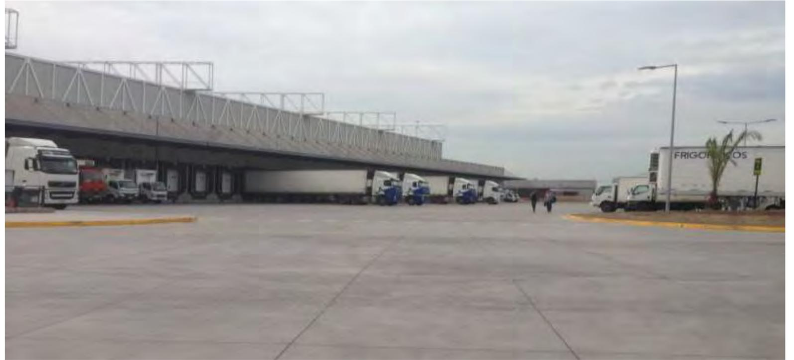
PAVIMENTOS EXTERIORES INDUSTRIALES EMPLEANDO SOLUCIONES DE PAVIMENTACIÓN CON PAVIMENTOS DE LOSAS CORTAS
