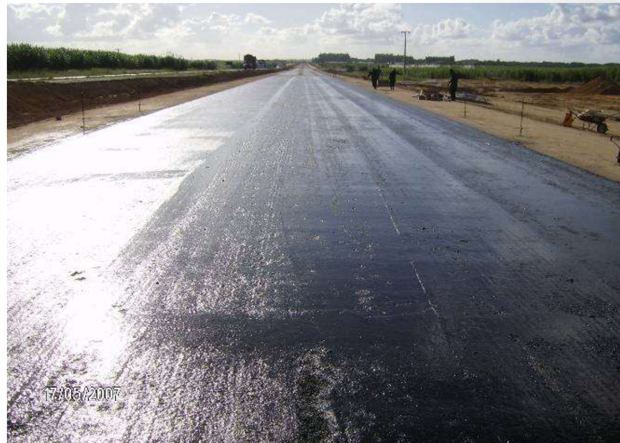
Pintura de cura - emulsão asfáltica
