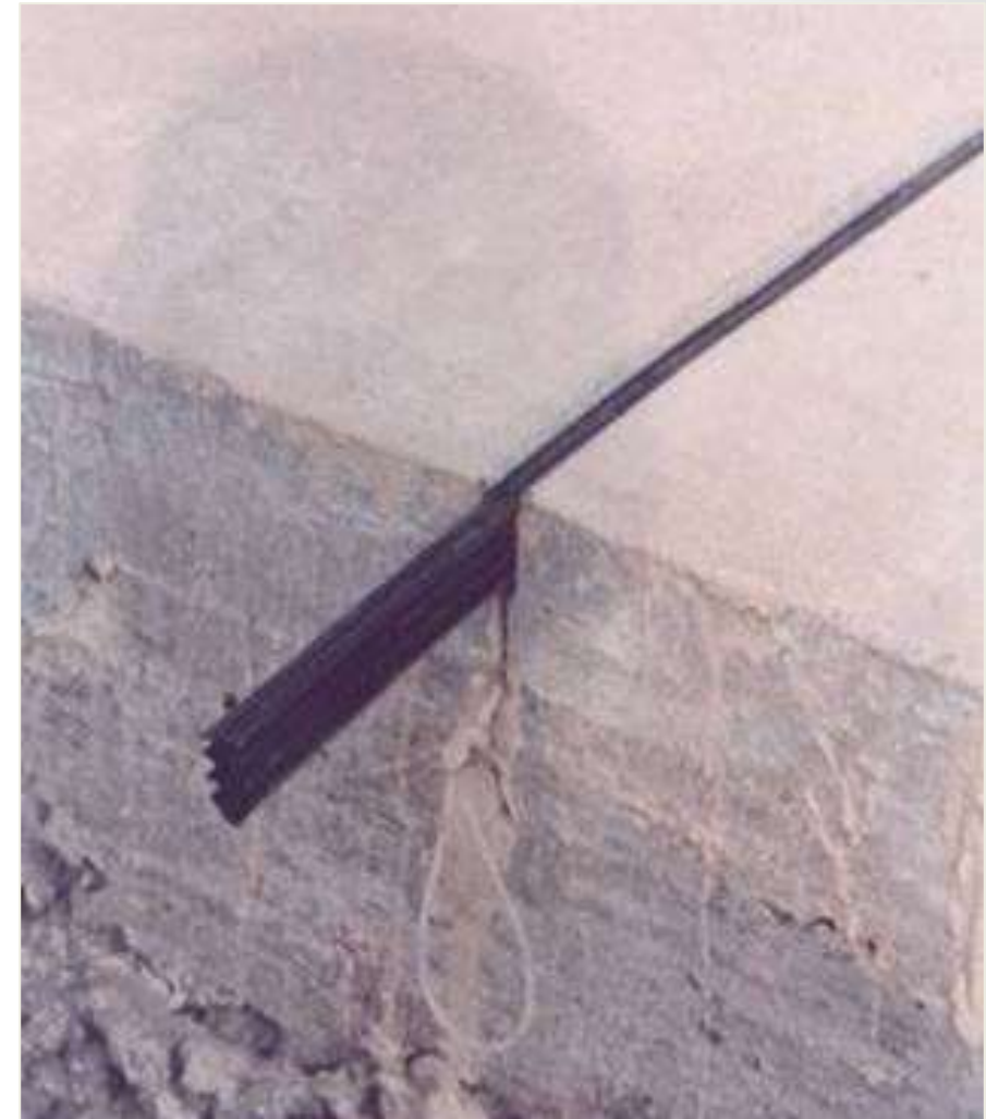
Selagem da junta pré-moldada 9
