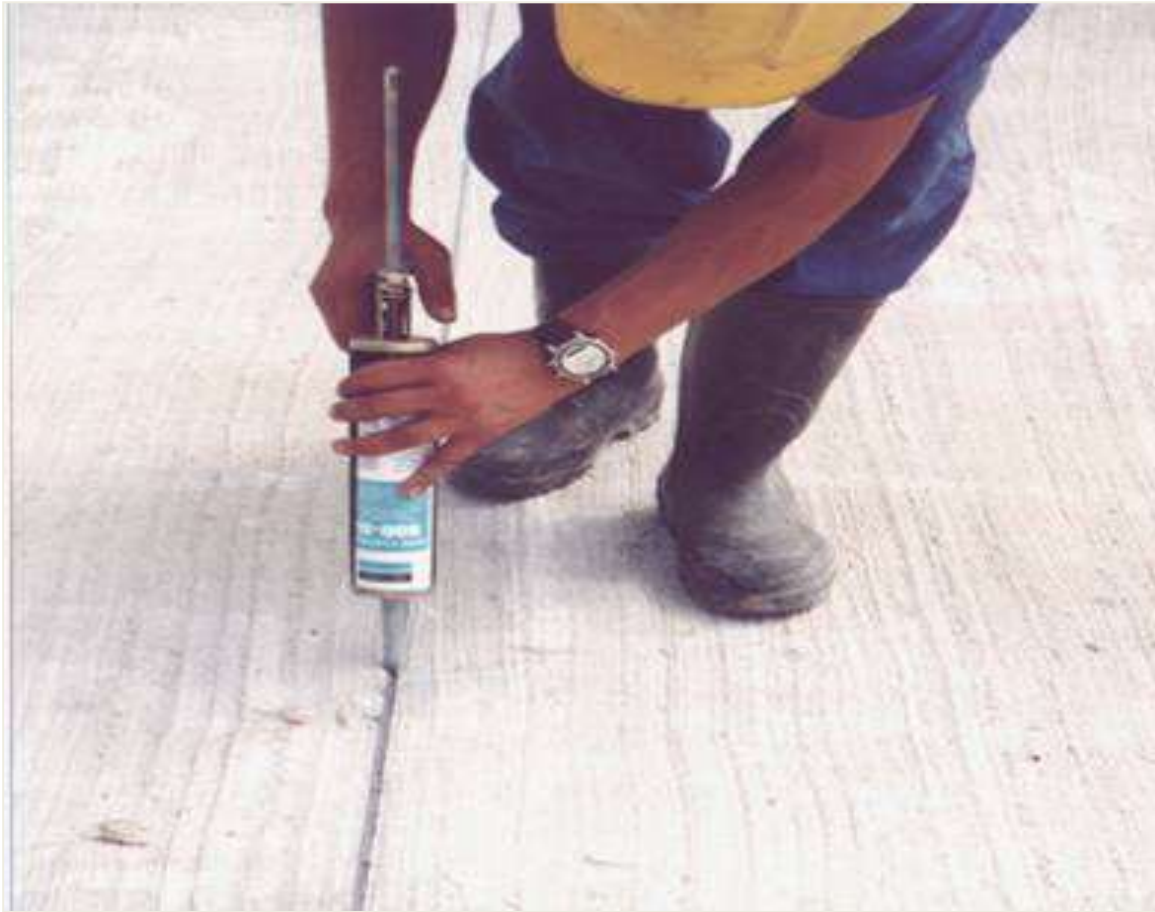
Selagem da junta a frio
