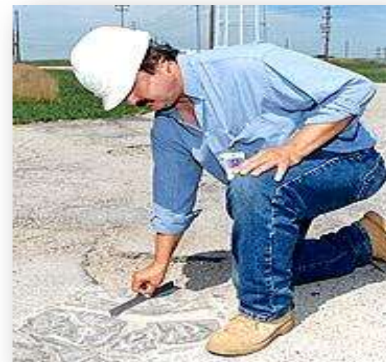
Reparo de pavimento
