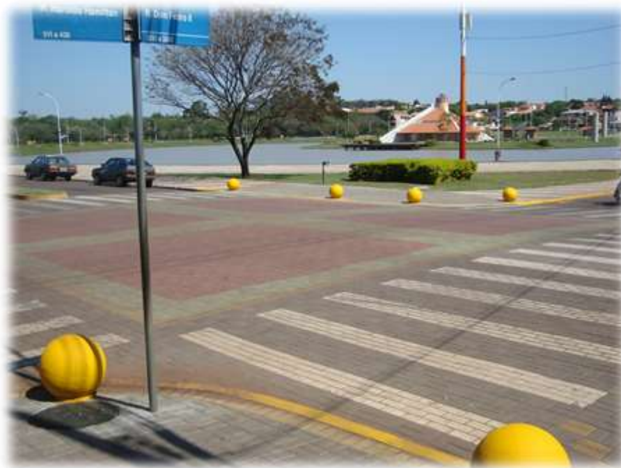
pavimento intertravado como ferramenta para moderação de velocidade!
