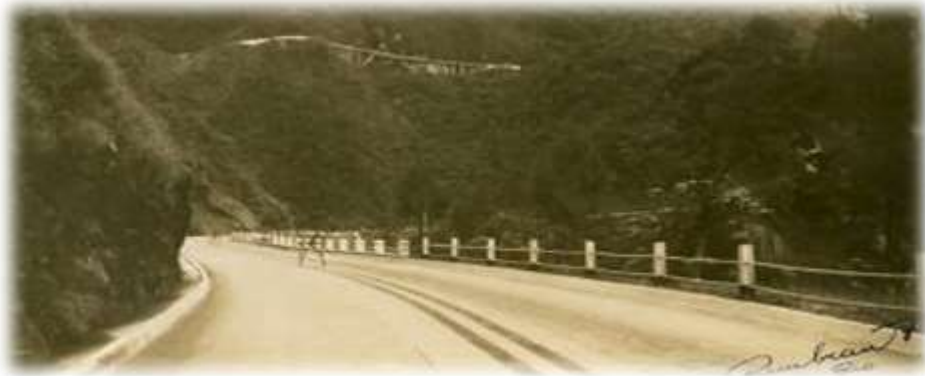
Rodovia Rio - Petrópolis
