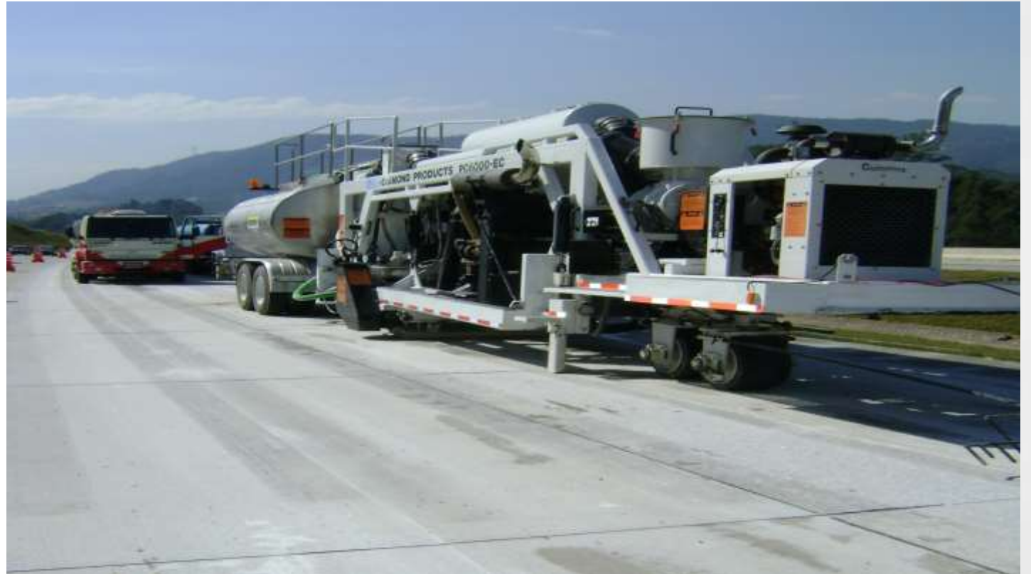
Diamond Grinding - Cepilhamento
