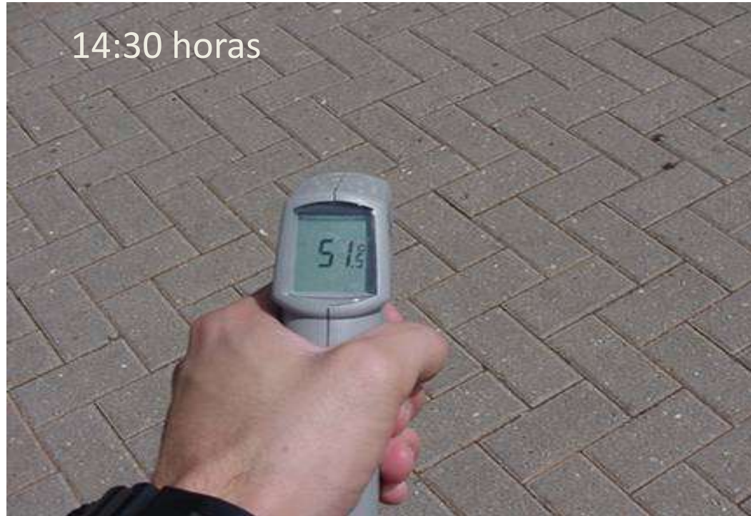
Pavimento de concreto Intertravado
