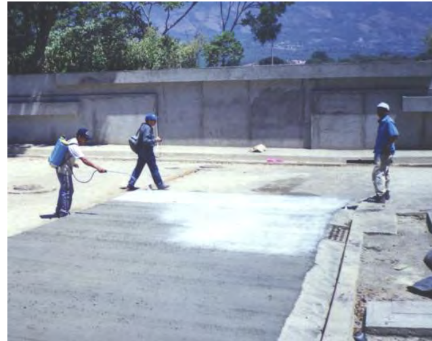
Equipamento manual para cura. Caso de pavimentação de estradas residenciais.
