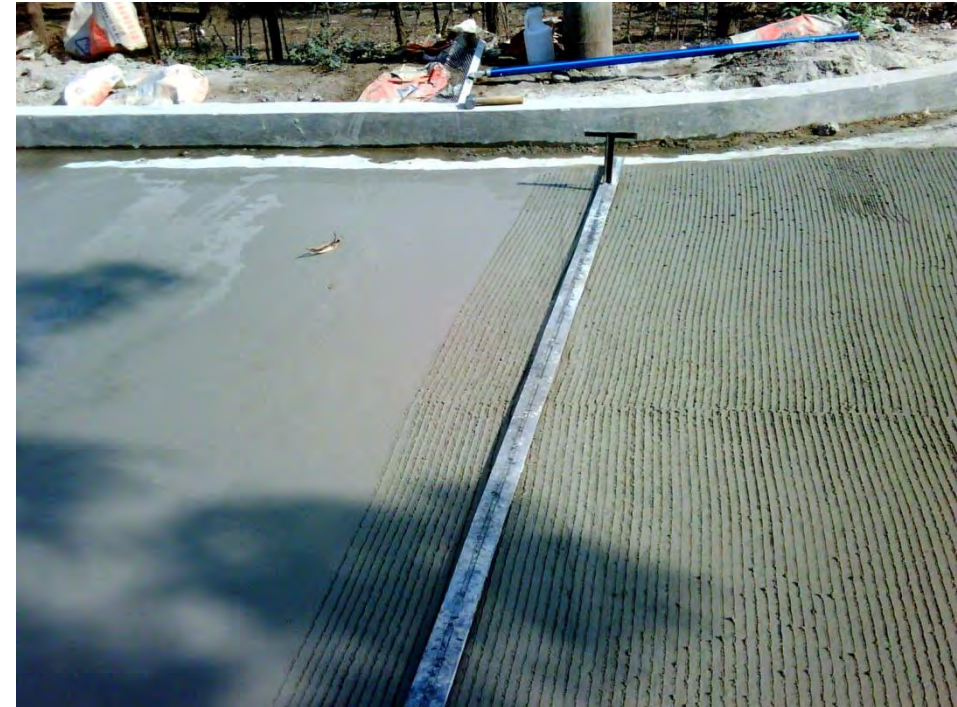
Ferramenta feita no local para corte fresco, aplicada em projetos municipais, com tráfego muito baixo.
