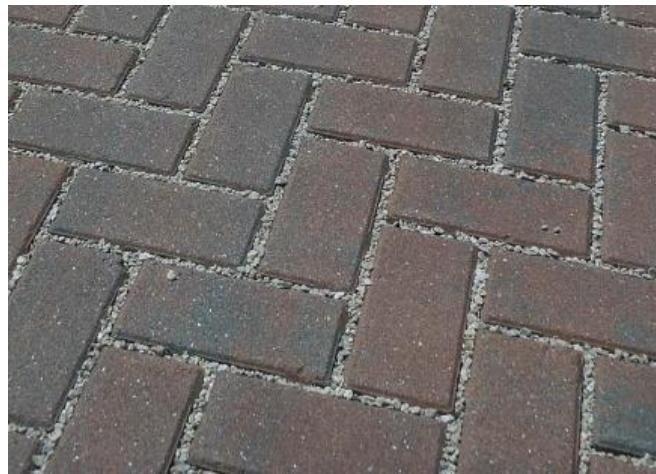
**Pavimento Intertravado permeável com áreas vazadas**
