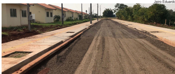
Base está pronta no conjunto habitacional de Guairá para receber o pavimento em concreto, agora é ajustar a dosimetria da cura
