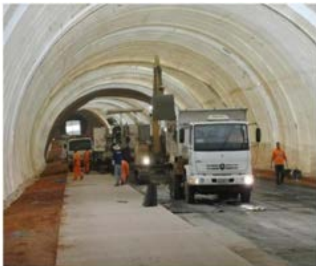
Serra de Nobres - BR 163/MT - Execução com vibroacabadora de formas deslizantes, sob túnel de PVC, inflável, para concretagem em período de chuvas (Whitetopping e Obra Nova).
