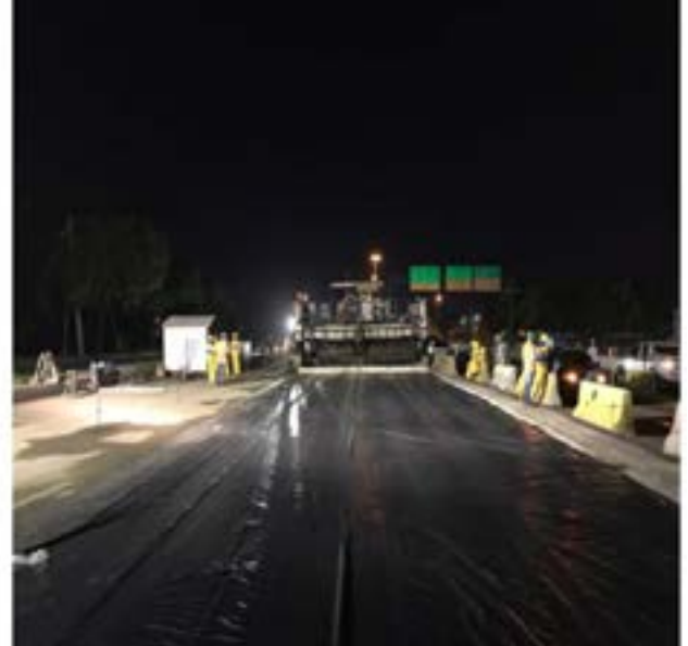
BRT Transbrasil - Rio de Janeiro/RJ - Execução com vibroacabadora de formas deslizantes, à noite.
