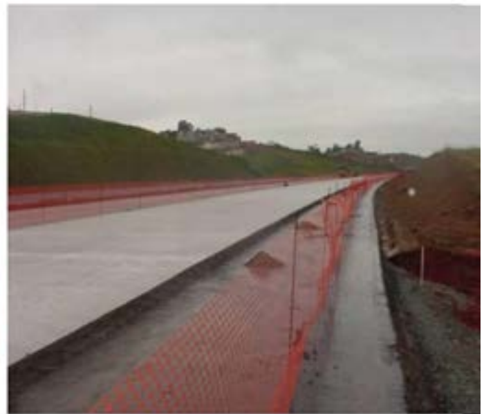
Proteção do pavimento acabado.
