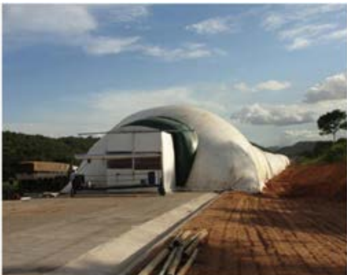
Serra de Nobres - BR 163/MT - Execução com vibroacabadora de formas deslizantes, sob túnel de PVC, inflável, para concretagem em período de chuvas (Whitetopping e Obra Nova).
