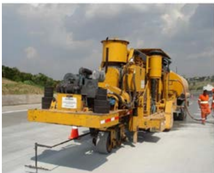
Micronivelamento do pavimento de concreto (Diamond grinding).
