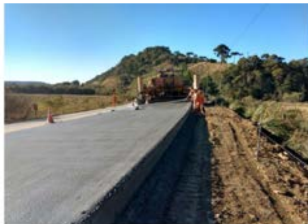
Rodovia SC 114 - Trecho Otacílio Costa - Lajes, com 36km de extensão. (Whitetopping).
