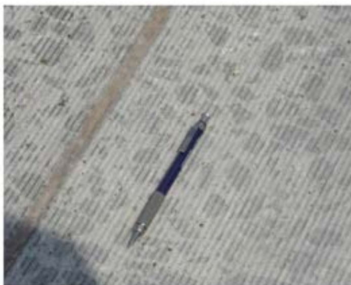
Micronivelamento do pavimento de concreto (Diamond grinding).
