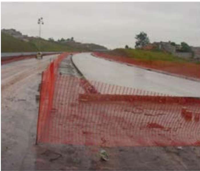
Proteção do pavimento acabado.
