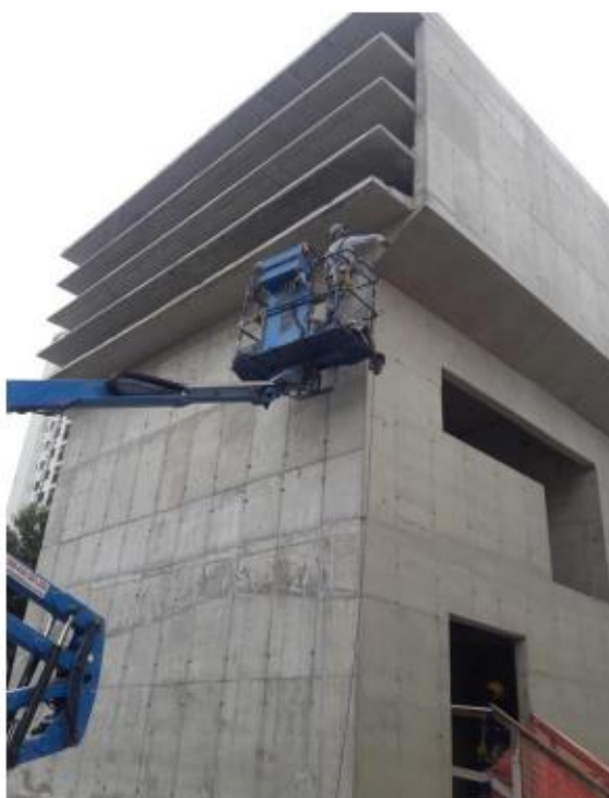
Tratamento de Concreto Aparente no Metrô - Chácara Klabin - Foto: Policoncreto Engenharia
