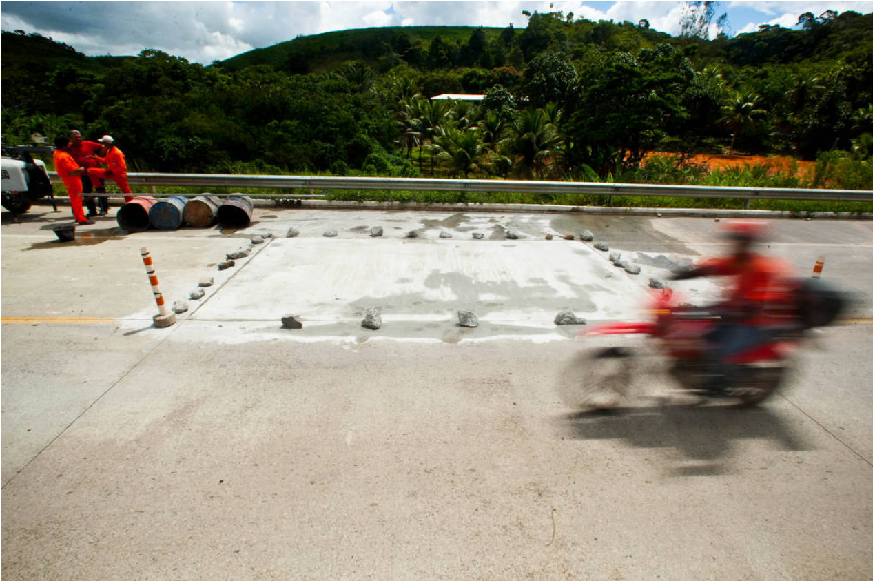
Operários trabalham na retirada de um bloco de concreto danificado em pista na BR-101, em Pernambuco - Danilo Verpa - 1.abr.11/Folhapress
