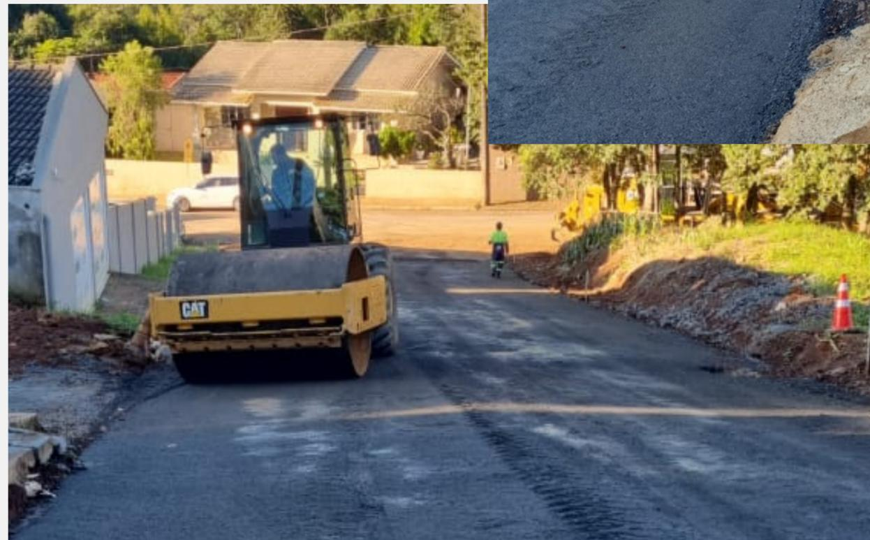
Após o preparo do sub-leito é executada uma camada de sub-base na espessura e largura projetadas utilizando Brita Graduada Simples (BGS).
