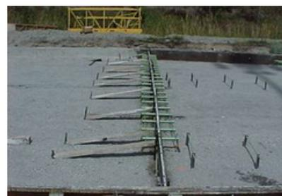
Em curvas com raios menores ou iguais a 30 m deve-se usar moldes curvados ou flexíveis com raios adequados. Não se recomenda o uso de moldes de madeira em locais onde haja a passada de equipamentos vibratórios.
