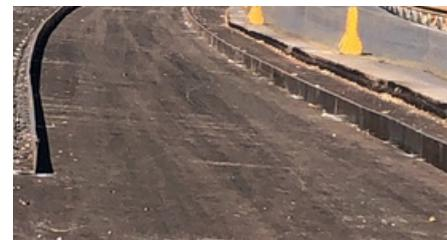
Recomenda-se que a tolerância quanto às cotas de projeto, quando verificadas pela régua de 3 m de comprimento, seja de  $\pm 3$  cm para diferenças localizadas.
