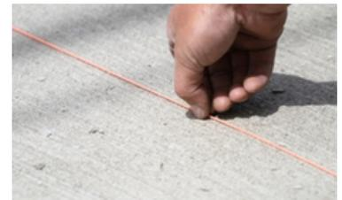
Para as juntas longitudinais, as linhas de demarcação são feitas com o concreto endurecido, a partir do momento que o profissional de marcação possa estar sobre o pavimento, sem danificar sua superfície.
