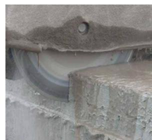
Os cortes primários devem ser realizados com profundidade projetada mínima entre 1/4 e 1/3 da espessura das placas de concreto para juntas transversais, e preferivelmente 1/3 da espessura das placas para juntas longitudinais. A profundidade dos cortes secundários, serão definidos conforme as condições necessárias para a preparação do reservatório de selagem das juntas prevista em projeto.
