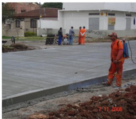
**Aplicação em grandes áreas:** é recomendado o uso de equipamento de pulverização com aplicação uniforme do composto. Bicos de pulverização e anteparo de proteção devem ser previstos, para evitar que o vento espalhe e perca o composto.
