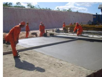
Esta aferição deve ser realizada desde o início ou partida da concretagem, inclusive considerando a região onde haja a junção de um concreto já endurecido com o concreto fresco, sendo esta uma área com grande possibilidade de desníveis. Todo e qualquer desnível deve ser corrigido imediatamente através de colocação de mais material ou por raspagem.
