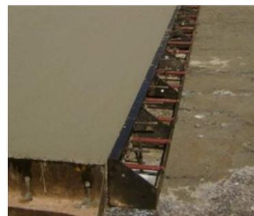
Junta de construção transversal
