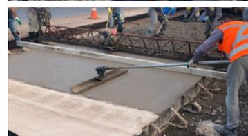
Ao fim de cada jornada de trabalho ou sempre que a concretagem tiver de ser interrompida por mais de 30 minutos, deverá ser executada uma junta de construção, cuja posição deve coincidir com a de uma junta transversal indicada no projeto. No caso em que não for possível coincidir com a junta transversal mais próxima, deve-se executar uma junta de emergência, definida em projeto, paralisando a concretagem com uma forma provisória que garanta as especificações desta placa.
