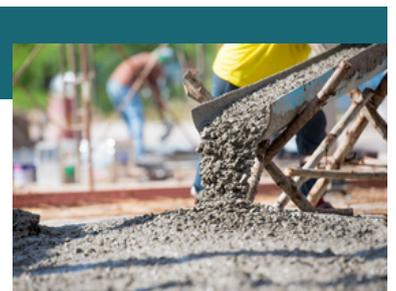
Sempre que possível o caminhão deve ingressar na área de lançamento para buscar uma descarga frontal a seção de pavimentação, assegurando que o concreto se mantenha uniforme, e que este se distribua em todos os espaços no interior dos moldes.
