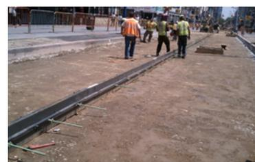
Junta de construção longitudinal
